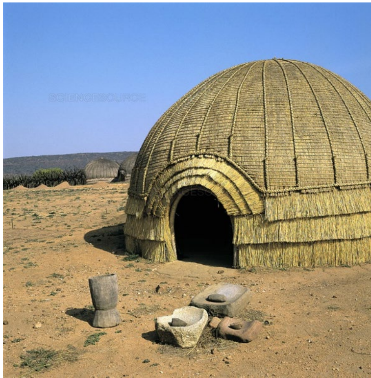
Fig. 76 – Une ixhiba dans le nord du KwaZulu-Natal. Des baguettes de bois trouvées localement sont tissées en forme de dôme, de manière à former une structure stable (le treillis). On y adjoint des excréments de bétail et de la terre de termitière. Ce treillis soutient le toit de chaume constitué de cannes fourragères ( Cenchrus purpureus ).
