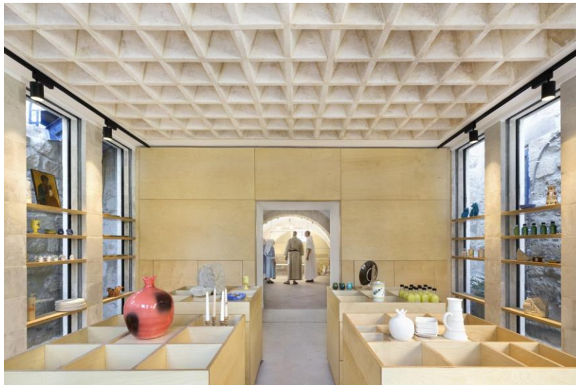
Figure 1.2 – Dalle en structure mixte pierre-métal, abbaye d'Abu Gosh à proximité de Jérusalem, architecte AAU Anastas, 2018
