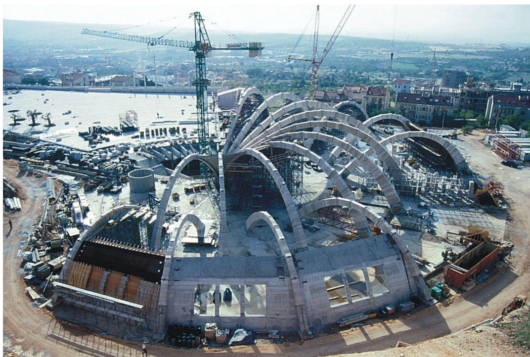
Figure 1.17 - Construction de la chapelle San Giovanni Rotondo, 2004, Renzo Piano
