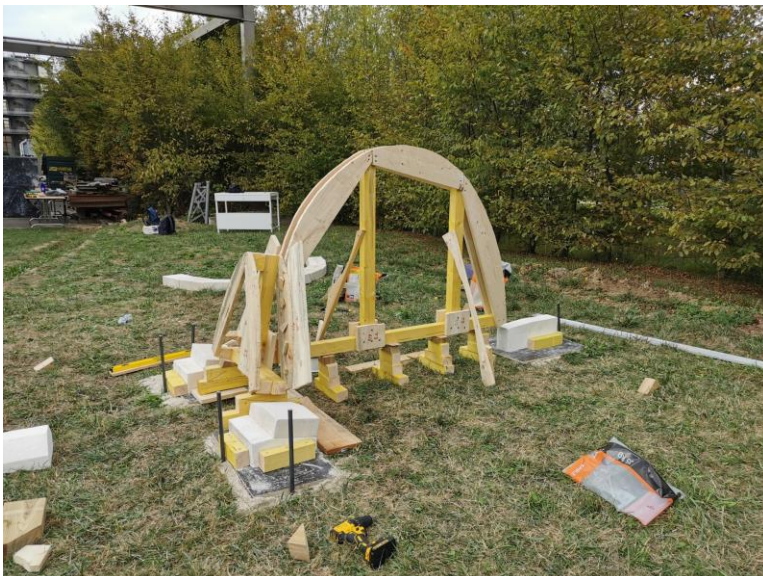
Figure f – Structures montées sur les cintres provisoires
