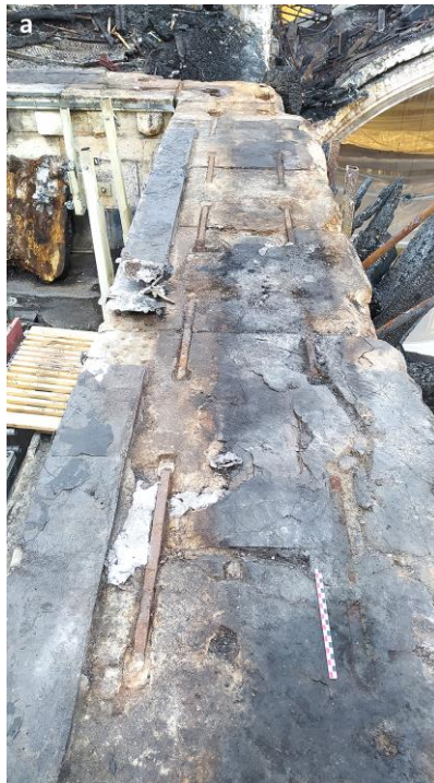
Figure 1.1 - Agrafes métalliques dans la partie supérieure du mur bahut de la cathédrale Notre-Dame de Paris, au niveau du chœur en partie sud (L'Héritier et al. 2023)
