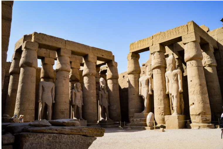
Figure 1.3 – Colonnes et linteaux constituant le système trilithique, temple d'Amon à Louxor, Égypte, 1550 AC (photo freepik.com)
