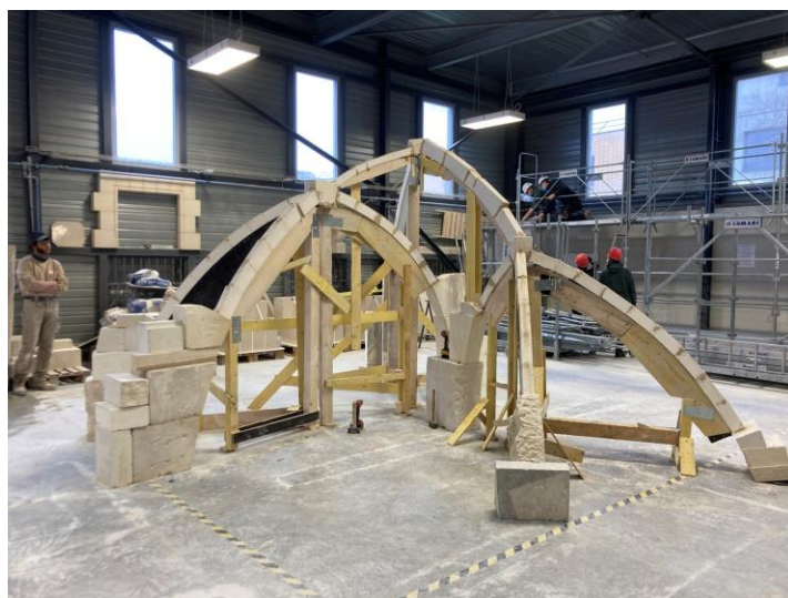
Figure c - Montage de la structure sur cintre
