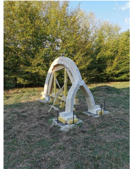
Figure f – Structures montées sur les cintres provisoires
