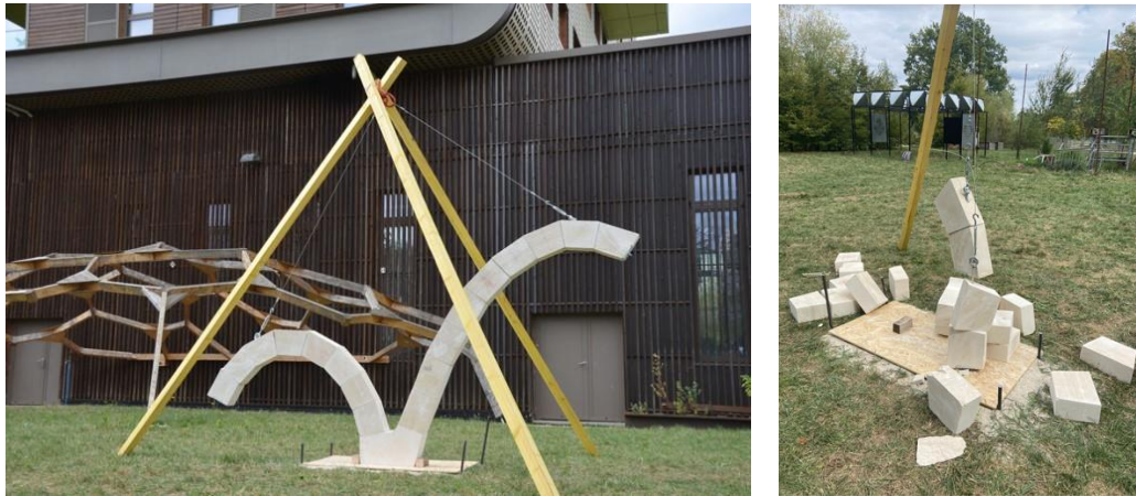
Figure 3.1 - Exemple d'une structure bloc à bloc et tirants, montée à joints secs, ayant rompu par torsion des joints dans la direction hors plan, après quelques heures, sous l'effet d'une charge de vent dynamique oscillante trop importante, la modélisation utilisée dans ce cas précis permettait de ne valider que le comportement statique dans le plan et ne pouvait donc pas anticiper ce type de rupture ; structure réalisée en septembre 2022 dans un cadre pédagogique (voir annexe A.2)
