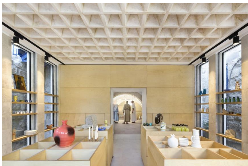
Figure 1.2 – Dalle en structure mixte pierre-métal, abbaye d'Abu Gosh à proximité de Jérusalem, architecte AAU Anastas, 2018
