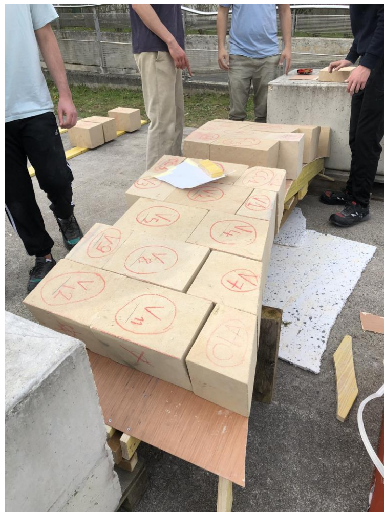
Figure j – Pose des blocs taillés de la passerelle sur le cintre
