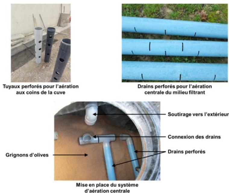
Figure IV- 4. Photos du système d'aération – Pilote in situ
