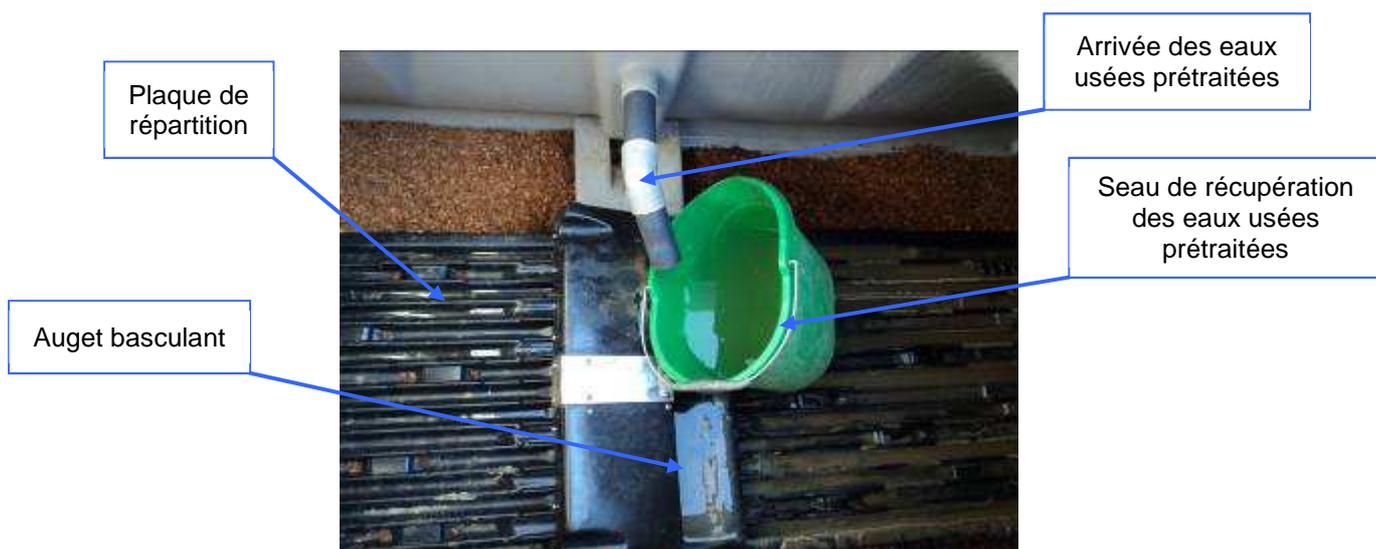
Figure II- 5. Prélèvement des eaux usées domestiques prétraitées – Vue du dessus
