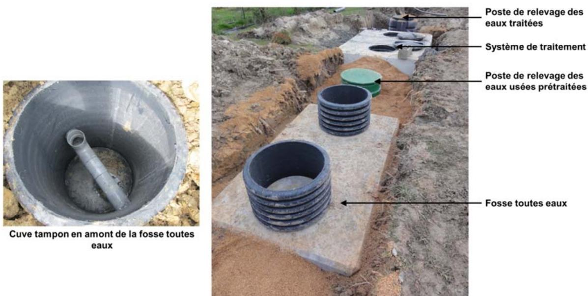
Figure IV- 1. Photo de l'installation du pilote in situ
