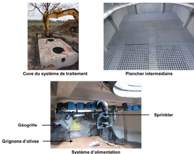
Figure IV- 3. Photos du système de traitement – Pilote in situ
