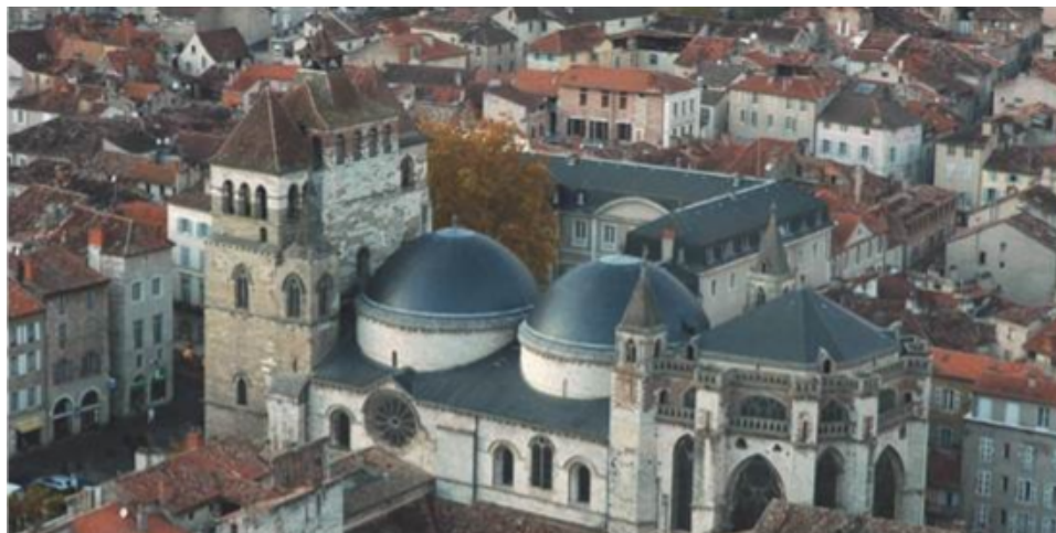
Figure 3.1 – Quartier médiéval de Cahors (Charrier, 2013)
