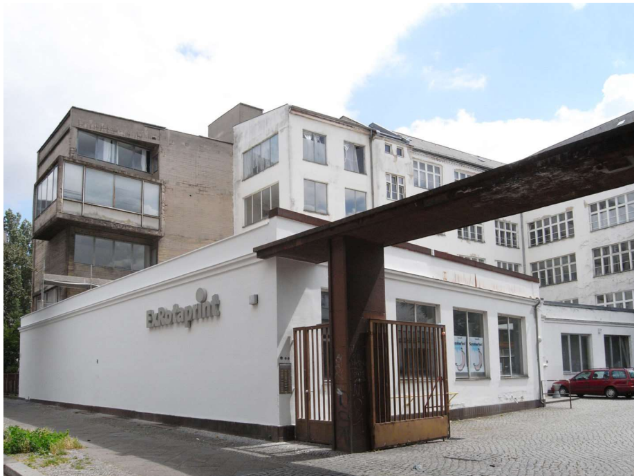
Illustration 11 : Aile ouest d'ExRotaprint, prise en photo depuis l'entrée principale du lieu. Les deux pièces de Reprodukt se trouvent au coin du bâtiment blanc, au quatrième étage. Le rez-de-chaussée, au premier plan sur la photo, abrite une cantine ouverte au public.
