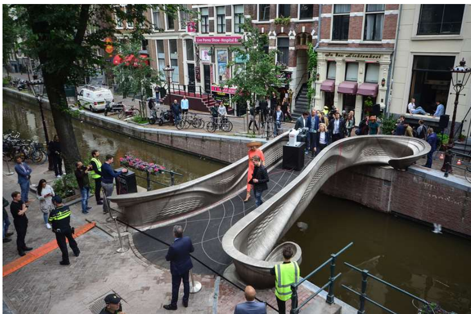
Figure 1 Passerelle fabriquée en fabrication additive WAAM par MX3D [6].
