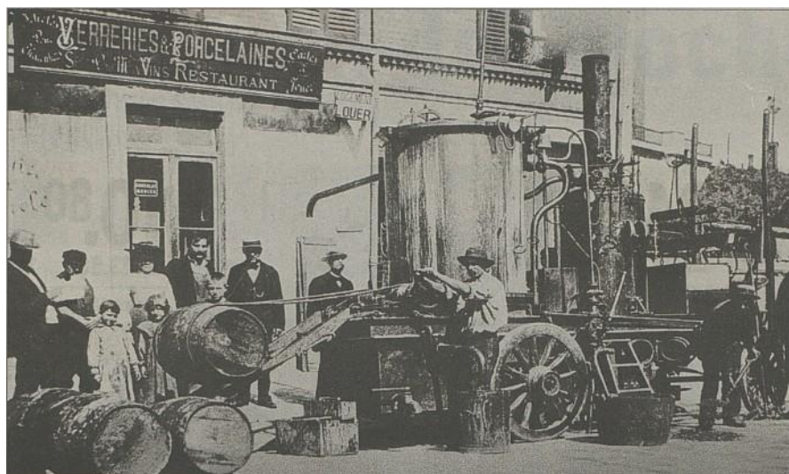
Figure A.2 Ernest GUGLIELMINETTI mis en œuvre son idée à Monaco avec la « première » machine capable de chauffer du goudron pour une application dans une rue. (G. T. G., 2002).
