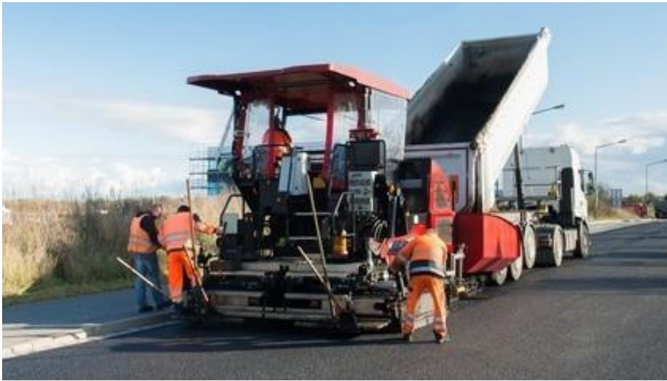
Figure 1.14 Photo d'un finisseur alimenté par un camion sortant d'une centrale d'enrobage (site internet PME BTP, n.d.).
