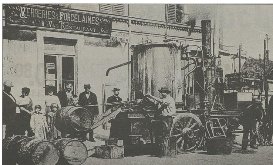
Figure A.2 Ernest GUGLIELMINETTI mis en œuvre son idée à Monaco avec la « première » machine capable de chauffer du goudron pour une application dans une rue. (G. T. G., 2002).
