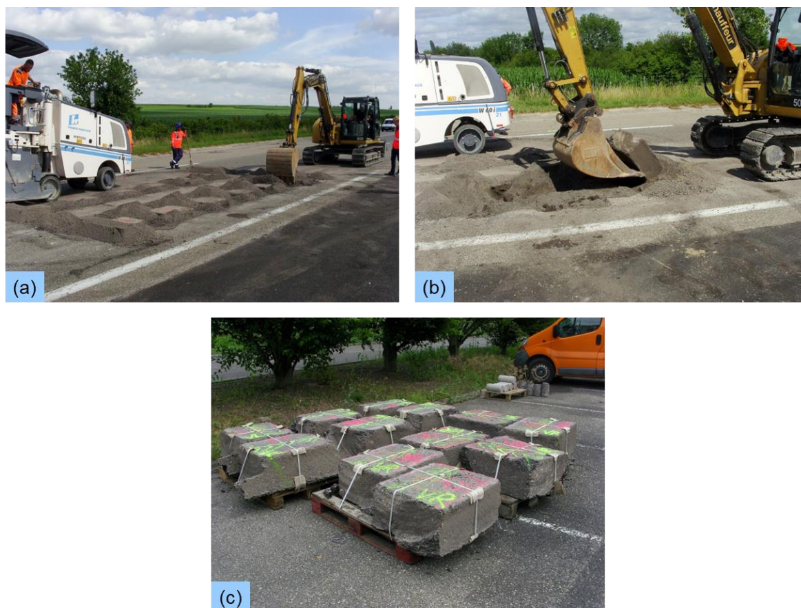
Figure 4.6 Prélèvement de douze plaques d'enrobés 700 x 500 x H. 300 mm sur toute la profondeur du corps de chaussée, sur une section de l'autoroute A35 au sud-ouest de Strasbourg le 18 juin 2018 (© Cerema). (a) Découpe par fraisage. (b) Extraction à la pelle. (c) Stockage sur palettes.
