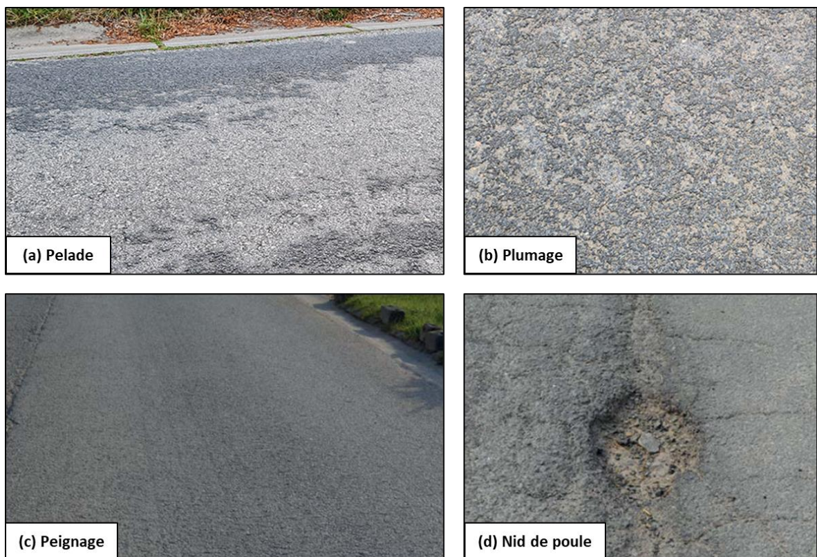
Figure 1.4 Désordres par arrachement (photos (a) et (b), site internet TP Demain, 2020 ; photos (c) et (d), CRR MF 89-rév1, Annexe, 2020, respectivement p. 19 et p. 16).
