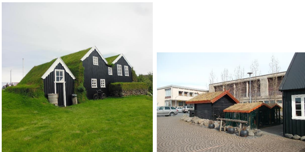
Figure 175: reconstruction de Mánarbakki et installation du Viking Village d' Hafnafjörður ; Clichés : SC, 2014.
