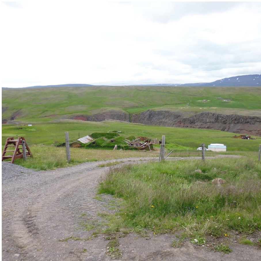
Figure 161: Tyrfingsstaðir, les bâtiments en restauration. Cliché : SC, 2013.
