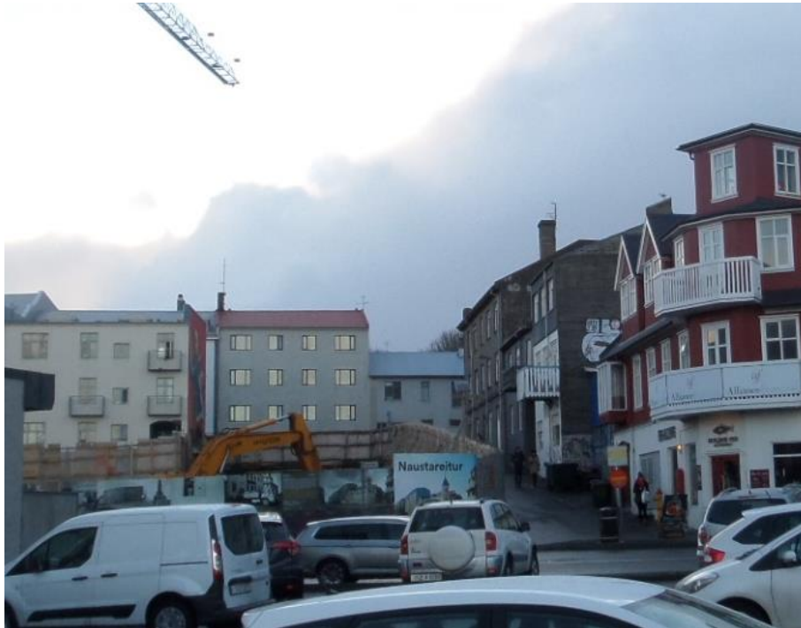
Figure 8: emplacement de l'Exceter House. Cliché : SC, février 2017.
