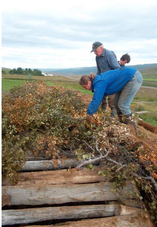
Figure 127: opération de couverture d'une bergerie, Hjarðarhagi (Est de l'Islande). Cliché : SC : 2012).
