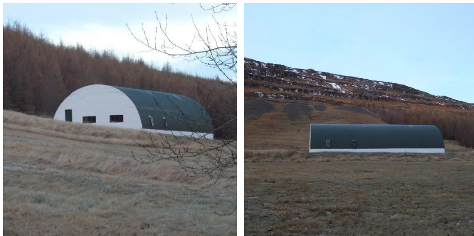
Figure 53: cabane Nissen à Skiðuklaustur, Est de l'Islande. Cliché : SC, janvier 2017.
