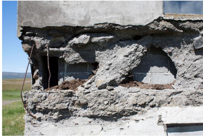
Figure 134: béton et tourbe. Cliché Gavin Lucas pour le Ruin Memory Project .
