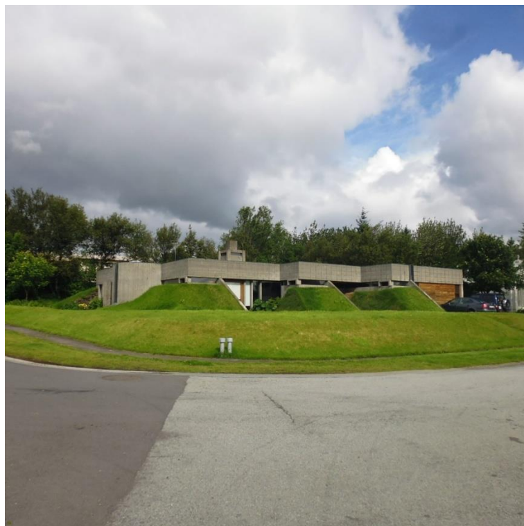
Figure 202: maison particulière de la rue Bakkaflof 1 à Garðabær par l'architecte Högná Sigurðardóttir. Cliché : SC, 2014.
