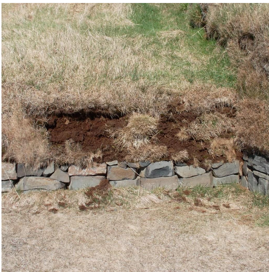
Figure 198: dégradations d'un des murs de la reconstruction de Stöng. Cliché : SC, 2013.
