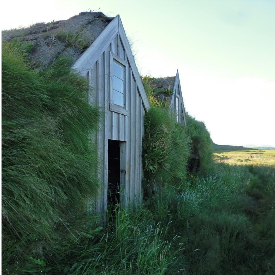
Figure 116: fjósbaðstofa de Galtastaðir fram à Hróarstunga dans l'Est. Cliché : SC, 2014.
