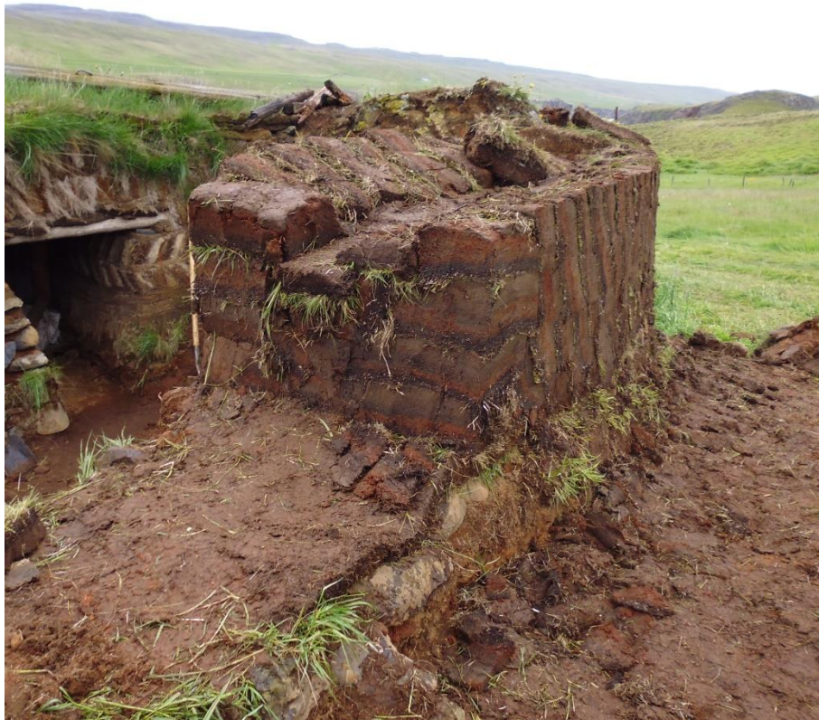
Figure 126: remplissage d'un mur de bergerie, Tyrfingsstaðir. Cliché : SC : 2013.
