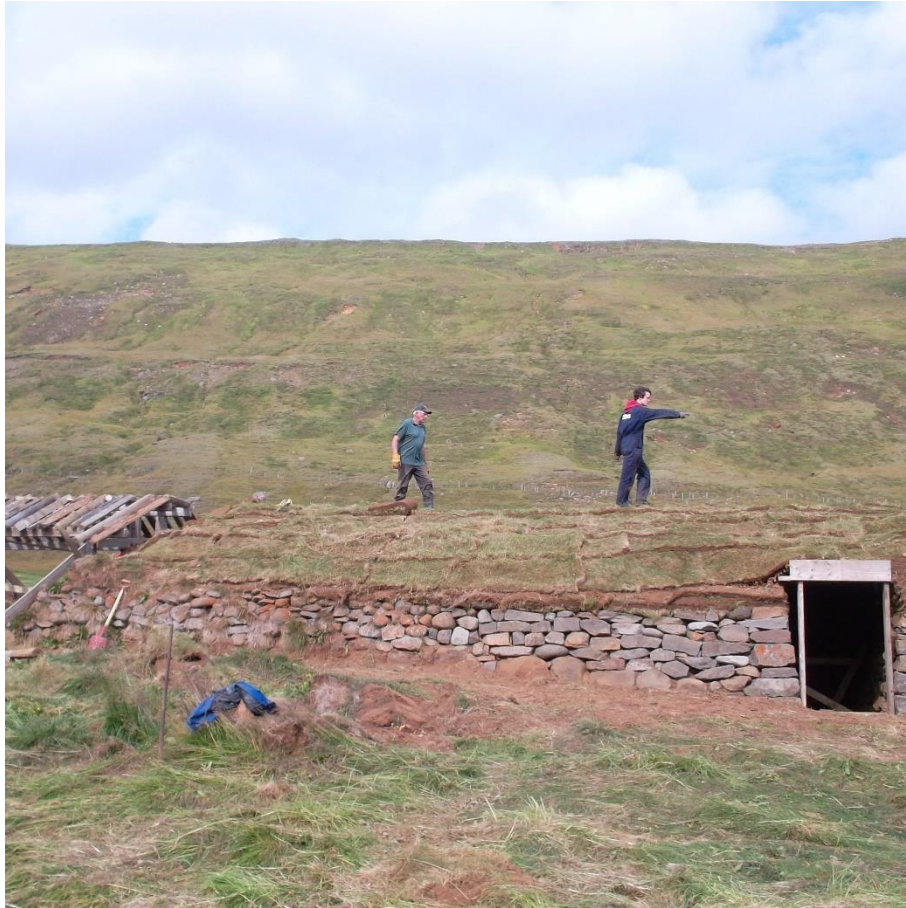
Figure 31: la couverture de la bergerie de Hjarðarhagi se confondant avec la montagne. Cliché SC, avril 2012.
