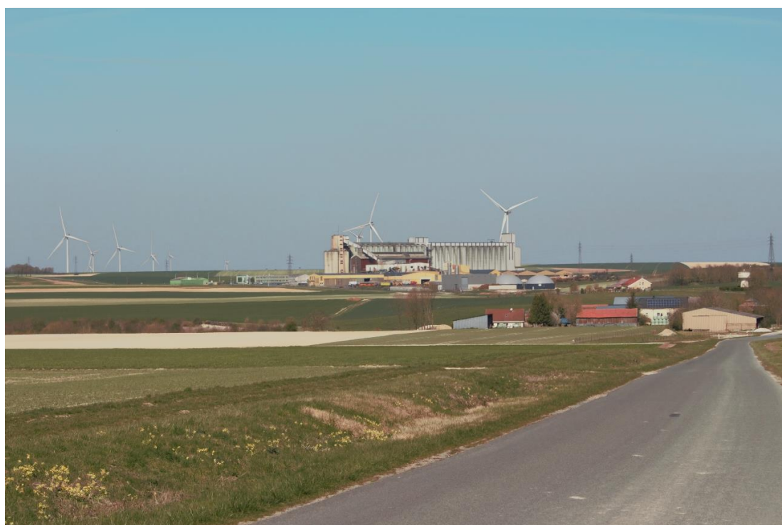
Figure 21 L'usine de déshydratation Luzeal de la luzerne à Pauvres (08) jouxtant les premières communes du Mont des Quatre Faux ©Jimmy Grimault, 2021
