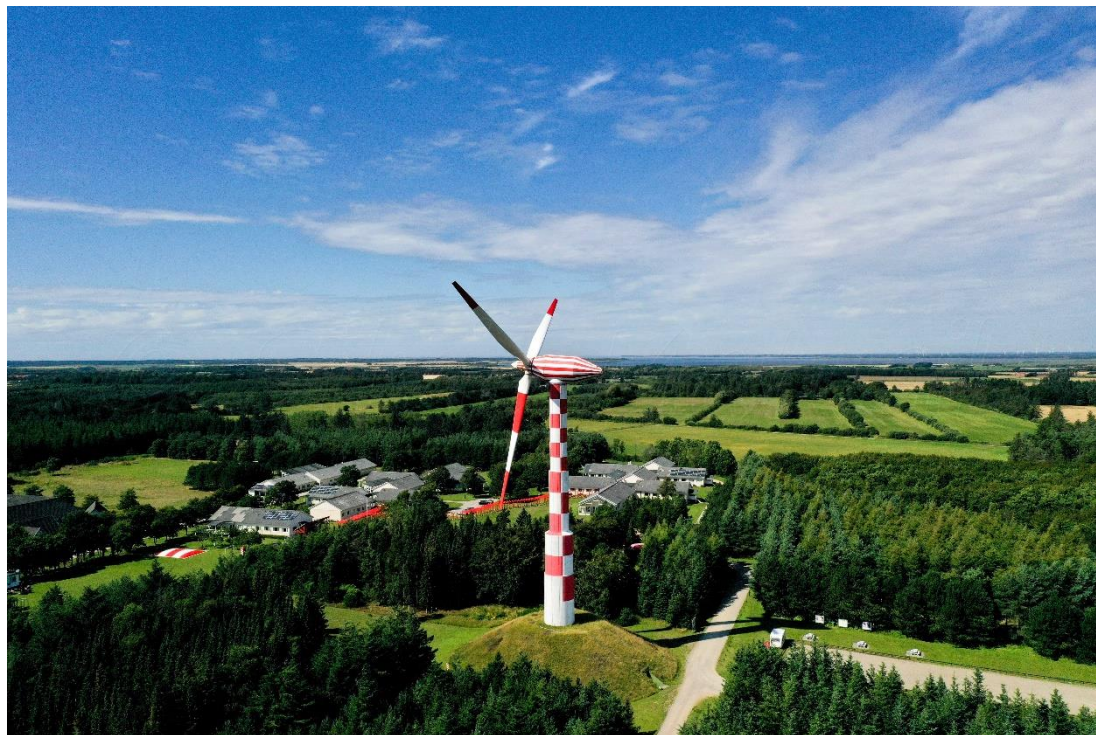
Figure 7 L'éolienne danoise Tvindkraft d'une hauteur de 54 mètres est équipée de trois pales de 27 mètres de long pour une puissance de plus d'un mégawatt © wind-turbine-models.com
