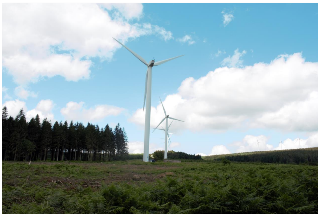
Figure 17 Parc éolien en Montagne Noire sur une parcelle déboisée ©Jimmy Grimault
