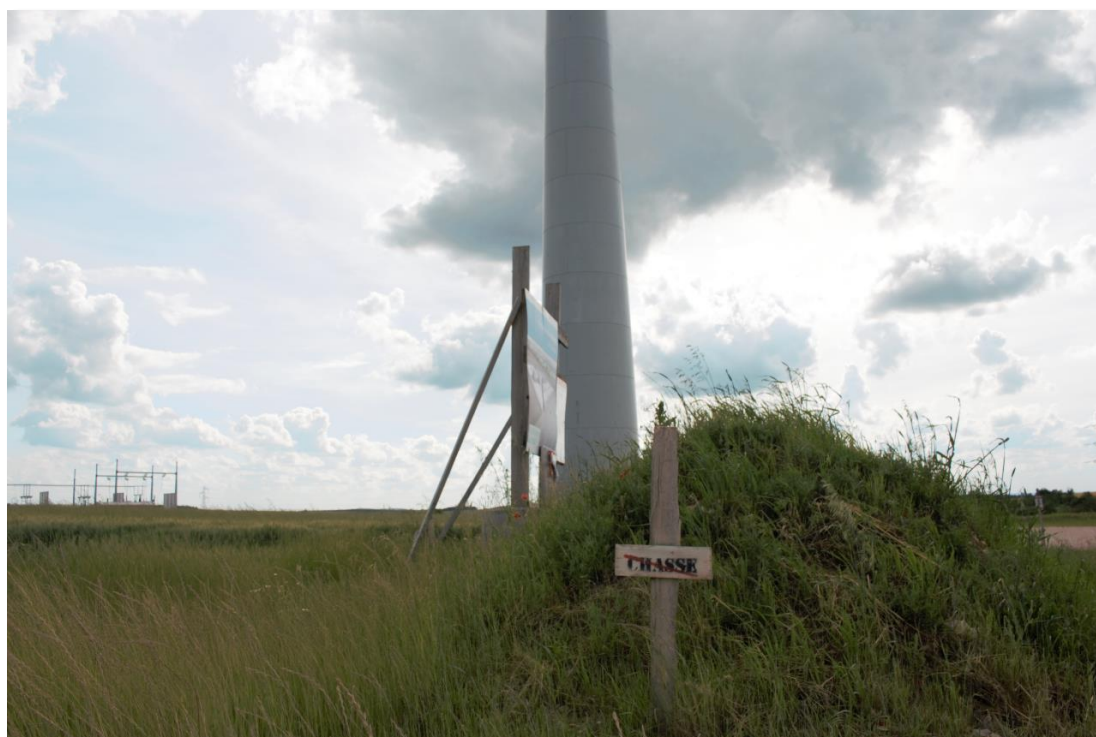
Figure 35 Une dépossession des espaces populaires à des fins d'accumulation ? Les parcs éoliens (ici en région Bourgogne-Franche-Comte) n'interdisent pas totalement d'autres activités à leurs abords contrairement aux parcs photovoltaïques qui sont grillagés ©Jimmy Grimault, 2021
