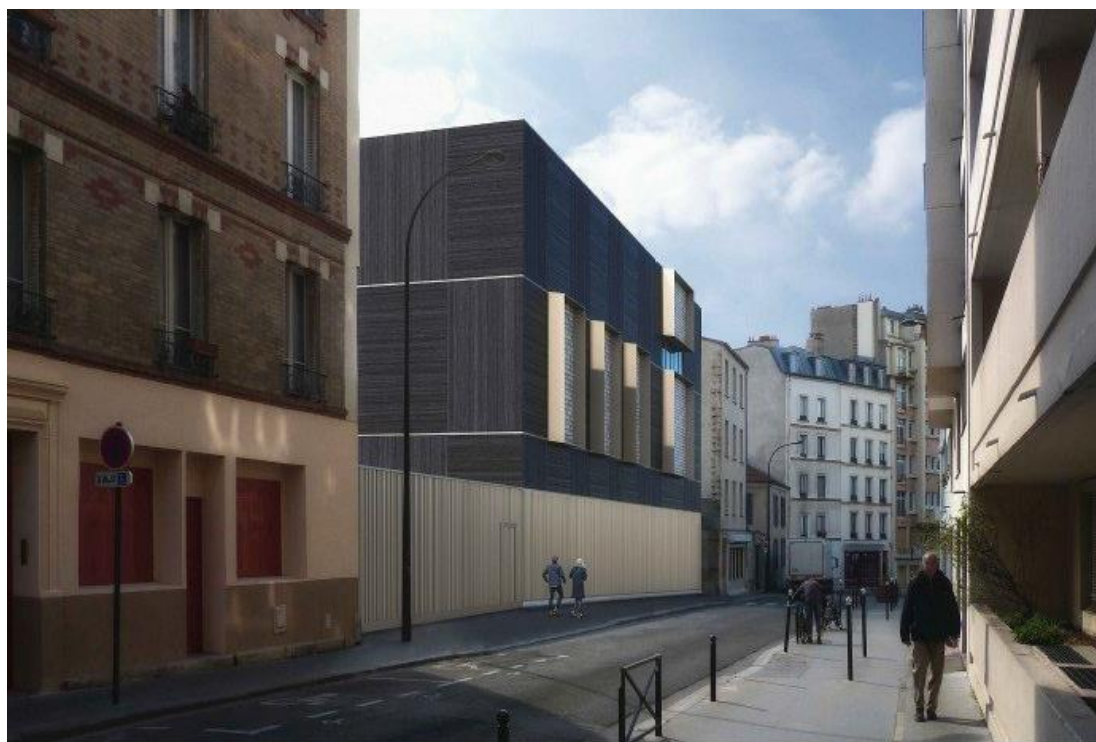
Figure 86 Exemple de poste électrique urbain à Tolbiac inséré dans un bâtiment architectural. Point de vue depuis le 24 Rue du Moulinet, 13 ème arrondissement de Paris 1580 © RTE, 2020
