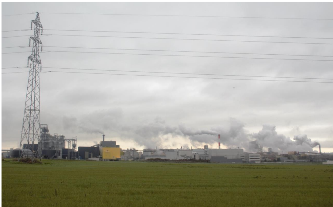
Figure 20 Site agro-industriel de Bazancourt (51) au nord-est de Reims, à quelques kilomètres du projet éolien du Mont des Quatre Faux. Ce site compte à la fois des installations de production et de recherche qui visent à développer de nouveaux débouchés (bioénergies, biocarburants, biomatériaux, « chimie verte », débouchés dans l'industrie cosmétique et pharmaceutique) ©Jimmy Grimault, 2021
