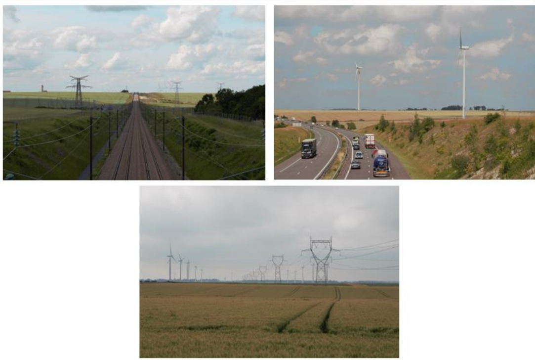
Figure 27 Des parcs éoliens dans le département de l'Yonne le long de la LGV Paris-Lyon ; Un parc éolien le long de l'autoroute entre Paris et Lille ; Des lignes d'éoliennes le long d'une ligne haute tension en Nord-Pas-de-Calais ©Jimmy Grimault, 2021
