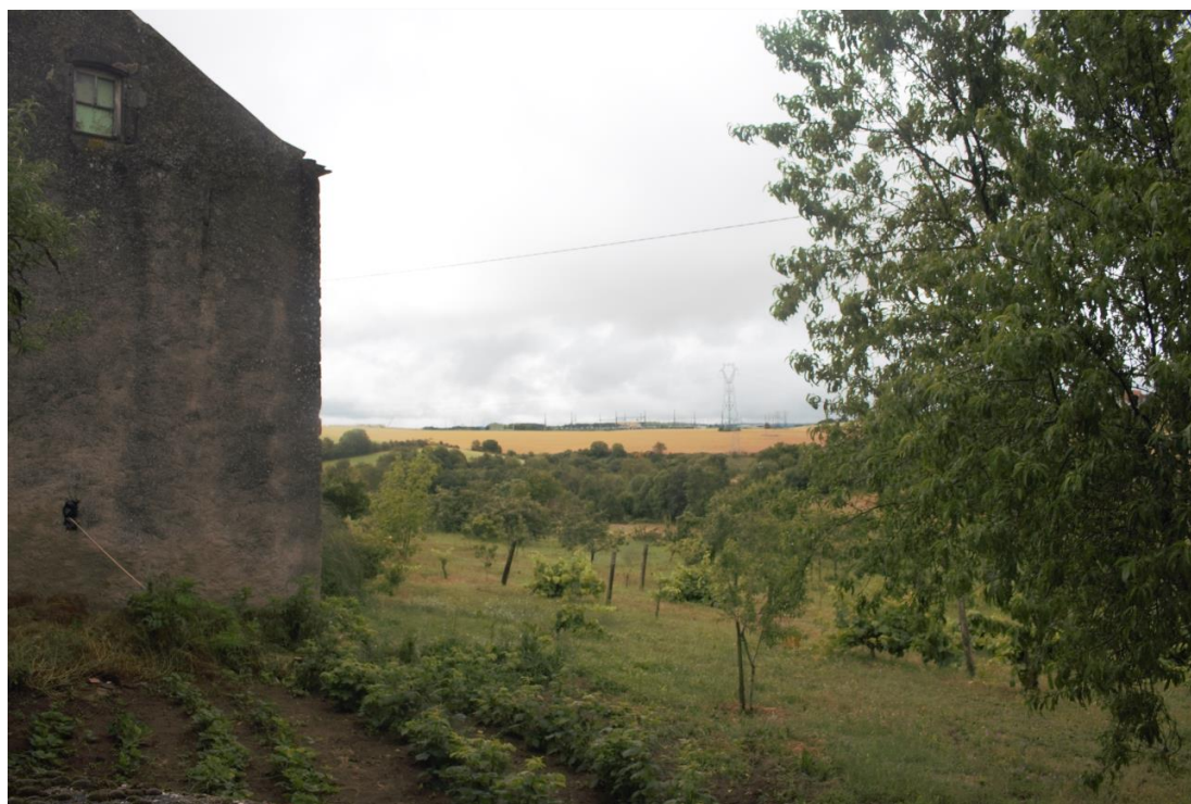
Figure 34 Photographies réalisées au hameau de Ayres (12) : au premier plan un jardin cultivé et ses arbres fruitiers, au second plan des pylônes et le transformateur électrique Sud-Aveyron en construction ©Jimmy Grimault, 2021
