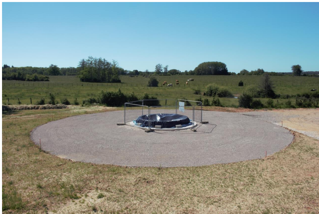
Figure 45 Un projet éolien en construction en Haute-Marne dans un contexte herbager où l'effet de contraste, le décalage entre deux mondes, est prégnant. Cela rappelle les travaux de Françoise Zonabend sur la presqu'île du Cotentin 926 commentés par Annaïg Oiry et imagés à travers une photographie de l'usine de retraitement des déchets de La Hague au milieu des landes 927 . ©Jimmy Grimault, 2021
