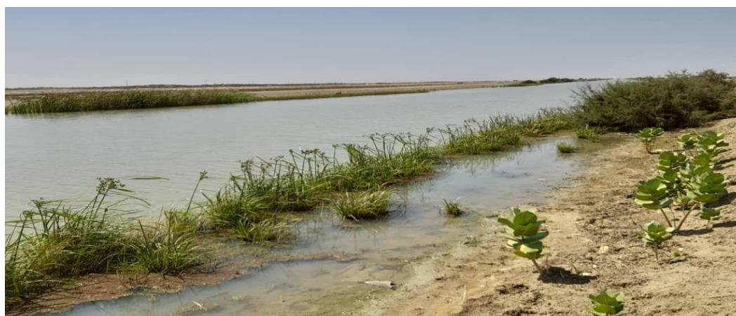
Photo 1. 32: Canal de L'Aftout long de 80 km et creusé à même de la dépression littorale saline menant vers Nouakchott
