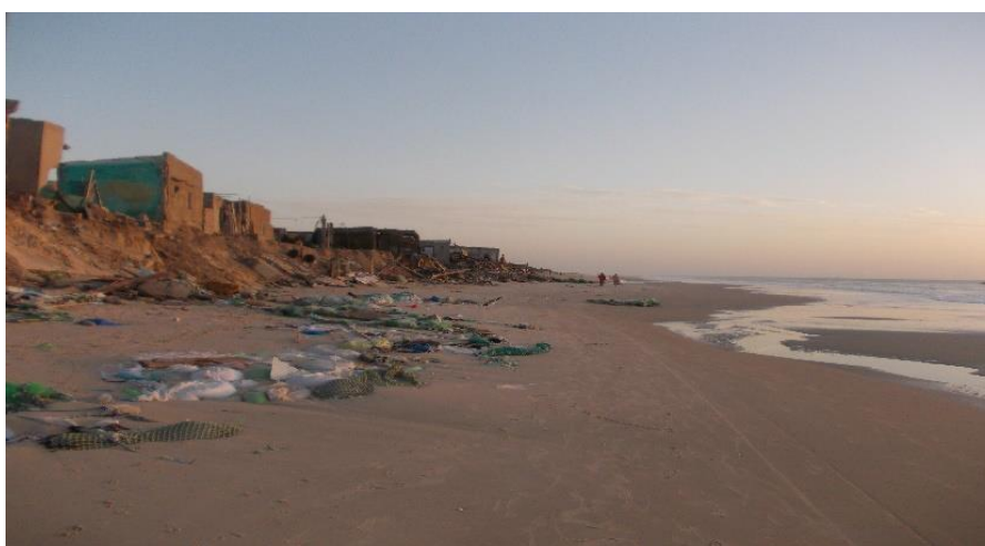
Photo 1. 1: Rivage érodé de Ndiago, Novembre 2018 avec chute du bâti sous l'angle 1
