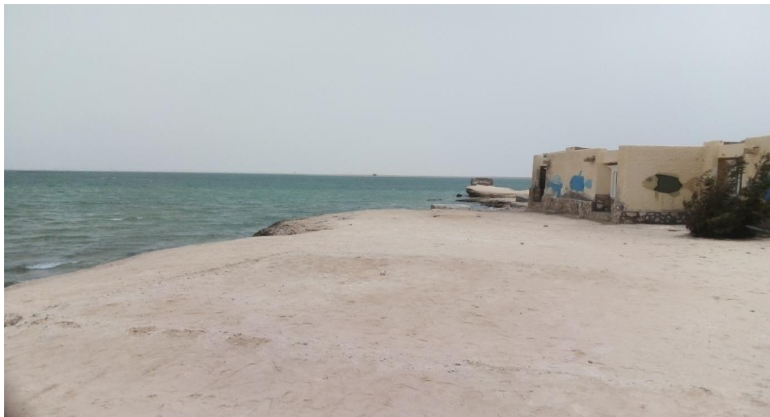
Photo 1. 34:Baie de l'Etoile et Erosion côtière des falaises avec les constructions qu'elles abritent, bientôt ces bâtiments construits en 1972, vont disparaître
