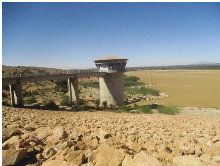
Figure 1-9 : Etat du barrage El Houwareb en 2015 (*)
