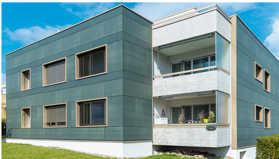
FIGURE 1.23 – Façade BIPV avec les modules sérigraphiés Suncol de chez SUNAGE [29]
