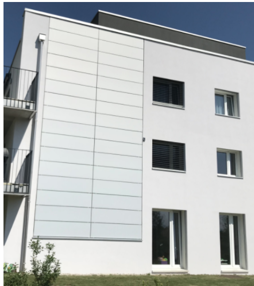
FIGURE 1.10 – Façade utilisant la technologie Solaxess en Suisse [14]
