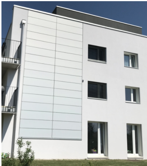
FIGURE 1.10 – Façade utilisant la technologie Solaxess en Suisse [14]
