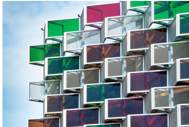
FIGURE 1.21 – BIPV utilisant des encapsulants colorés couplés à des cellules CdTe (Soltech), à Linköping, Suède. [27]
