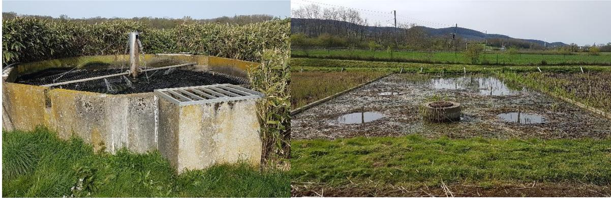
Figure II.8 : Photos du lit bactérien (à gauche) et du premier étage de filtration de la STEU de Vercia en hiver après la coupe des roseaux (à droite).
