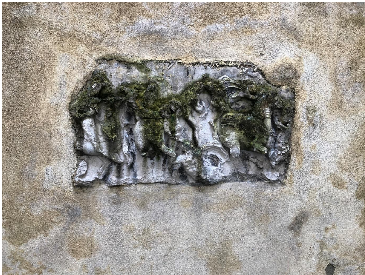
Photographie 12 – Vestige d'un relief situé dans l'arrière-cour du 19 place colonel Fabien à ancien emplacement du Change de Nancy
