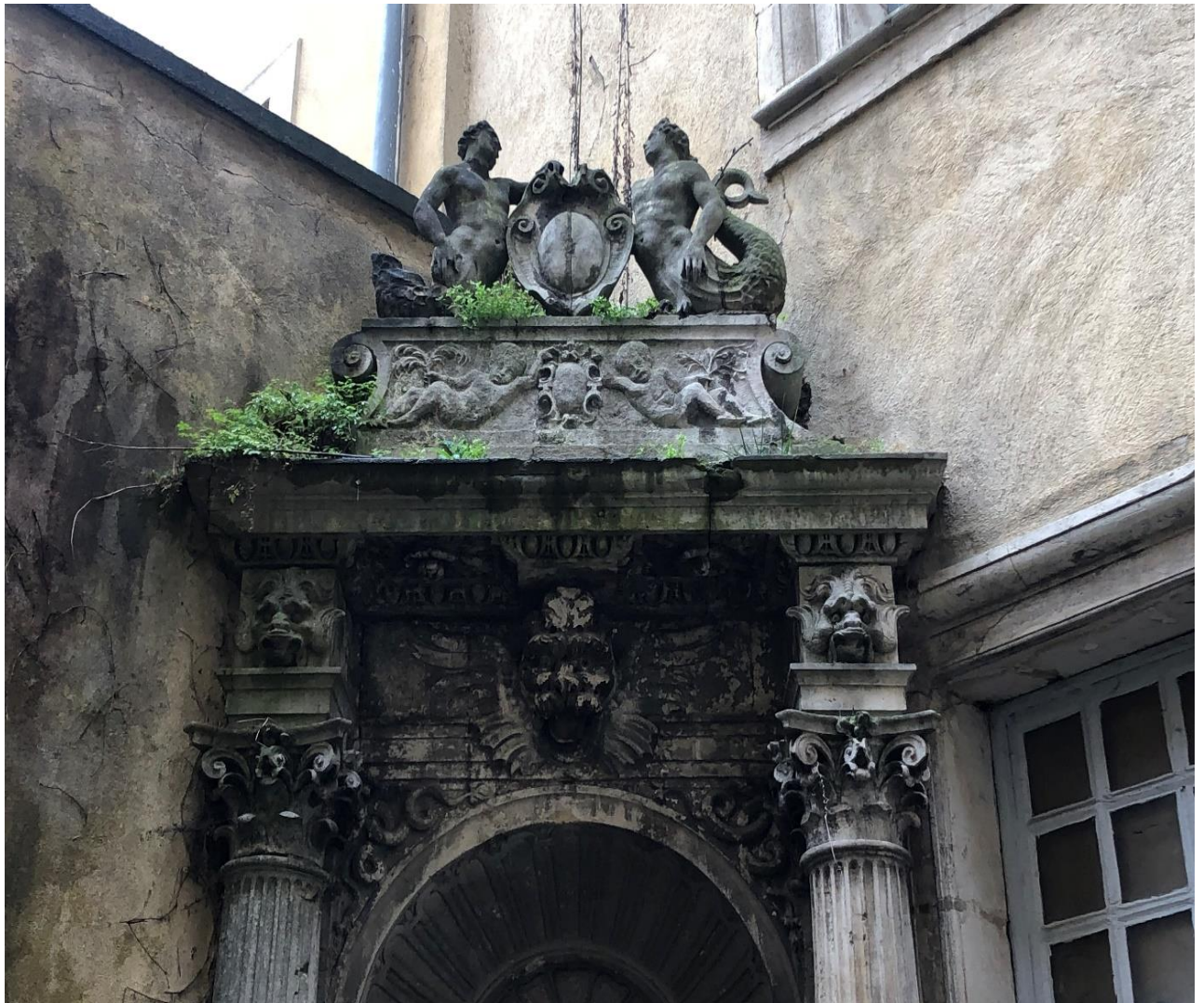
Photographie 11 – 2/2 Puits aux sirènes situé dans l'arrière-cour du 19 place du colonel Fabien ancien emplacement du Change de Nancy
