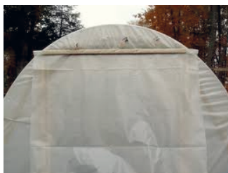
Installation de rideaux aux portes des serres
