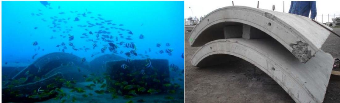
Photographie 4 : Récifs artificiels immergés de types sandwiches à t + 4 ans ; projet « CORAIL REUNION » (Source : Corailreunion.blogspot et CRPMEM)
