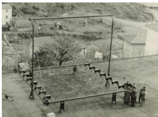
FIGURE 1.19 – Installation du prototype de concentrateur linéaire de Fresnel de Giovanni Francia à Marseille
