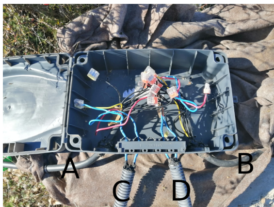
Figure 1.8 – Photo du boîtier de connexion actuel et schéma électrique des connexions du câble. Le brin 12 n’est pas raccordé car il n’est plus conducteur.
