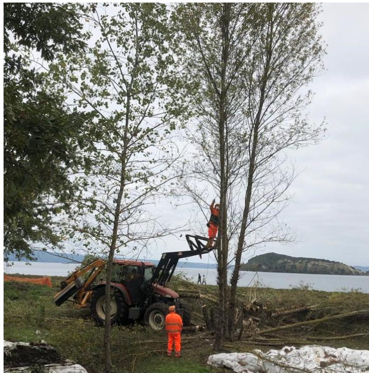
Figure 29 : il a été nécessaire de procéder à l'élimination des peupliers pour poursuivre la fouille. Cl. E. Lovergne
