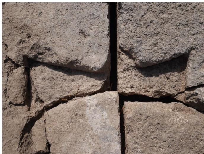
Figure 40 : vue de l'empreinte d'une des deux agrafes de bronze qui tenait ensemble les plaques de nenfro. Cl. M. Jaillet
