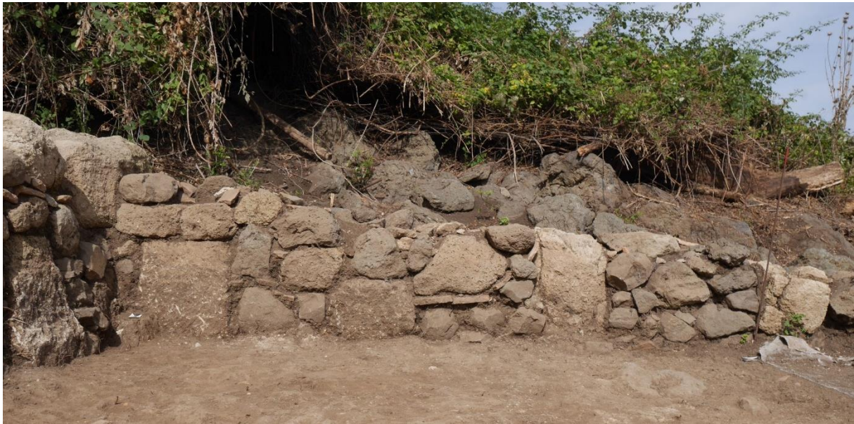
Figure 37 : vue latérale du mur ouest du bâtiment D. On distingue la technique « a sacchiera ». Cl. M. Jaillet
