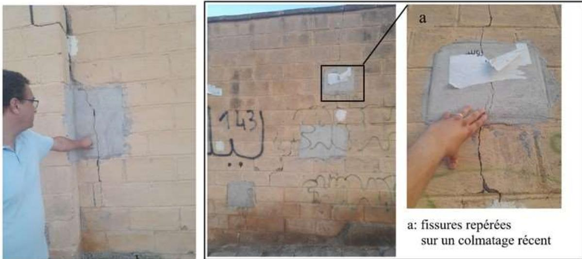
**Figure 19** : Fissures dans les murs de clôture en maçonnerie.
