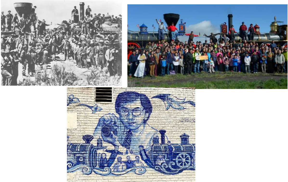
Figure 3-4-7, Figure 3-4-8, Figure 3-4-9, De gauche à droite, de haut en bas: Photo d'Andrew J. Russell East and West shaking hands at laying of last rail (1869), Photo de Corky Lee (2014), Une partie du mural Corky Lee (2022)
