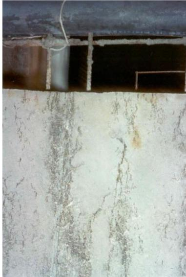
Figure 1-35 : Parement d'une pièce de béton armé ayant présenté une localisation du ressuage [13]
