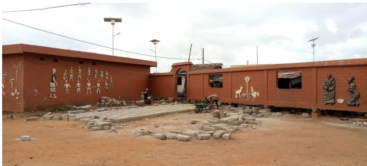
Photo 1 : Réhabilitation de la clôture des collectivités familiales
