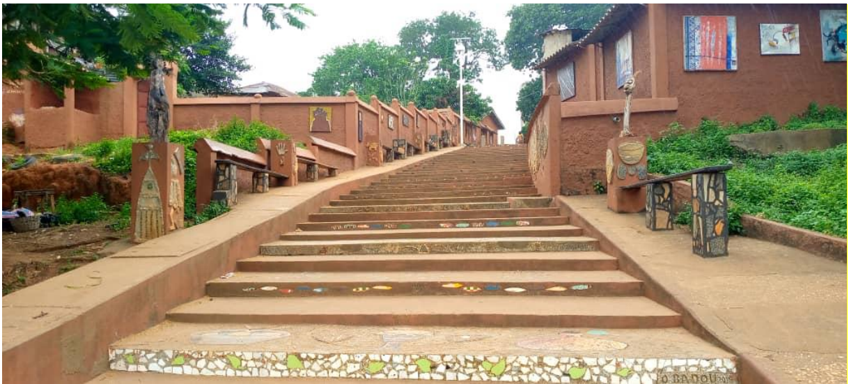
Photo 2 : Ruelle réhabilitée desservant la cour d'une collectivité familiale
