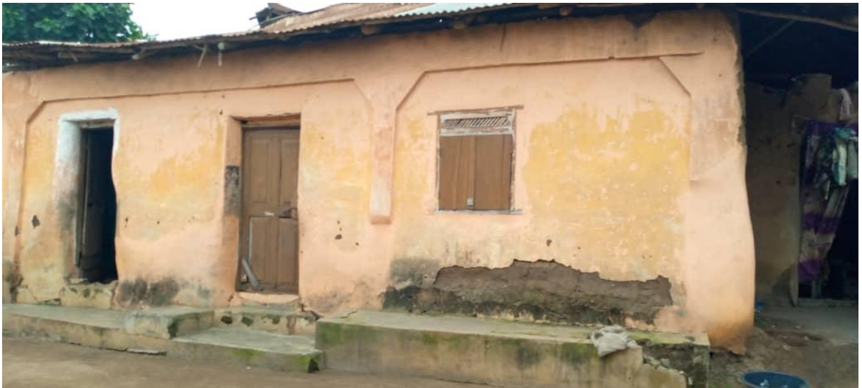
Photo 4 : Maison en terre de bas dans le quartier Akron
