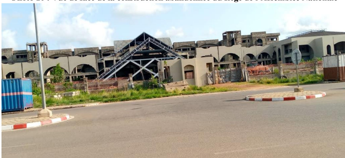
Photo 10 : Vue de face de la construction abandonnée du siège de l'Assemblée Nationale
