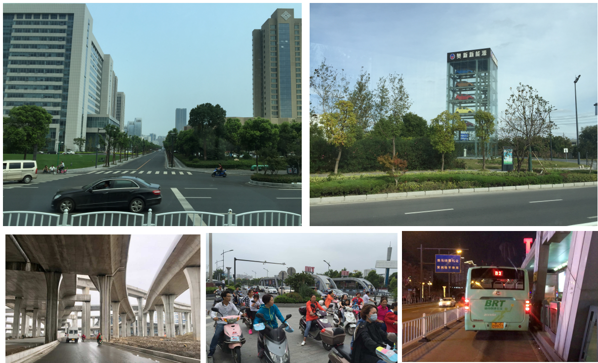
Figure 40: Yancheng est une ville industrielle émergente dès l'inauguration du siège industriel coréen Dongeng Yueda Kia Motors (plate-forme pour l'expansion de Kia Motors en Chine). Récemment, la ville a inauguré 22 km de viaducs, que renforce l'utilisation de la voiture. A Yancheng il y a une longueur totale de 16 km de BRT dès l'inauguration en 2010. De nombreux résidents ont choisi d'utiliser des motocyclettes électriques. Source: Auteur, 2016.
