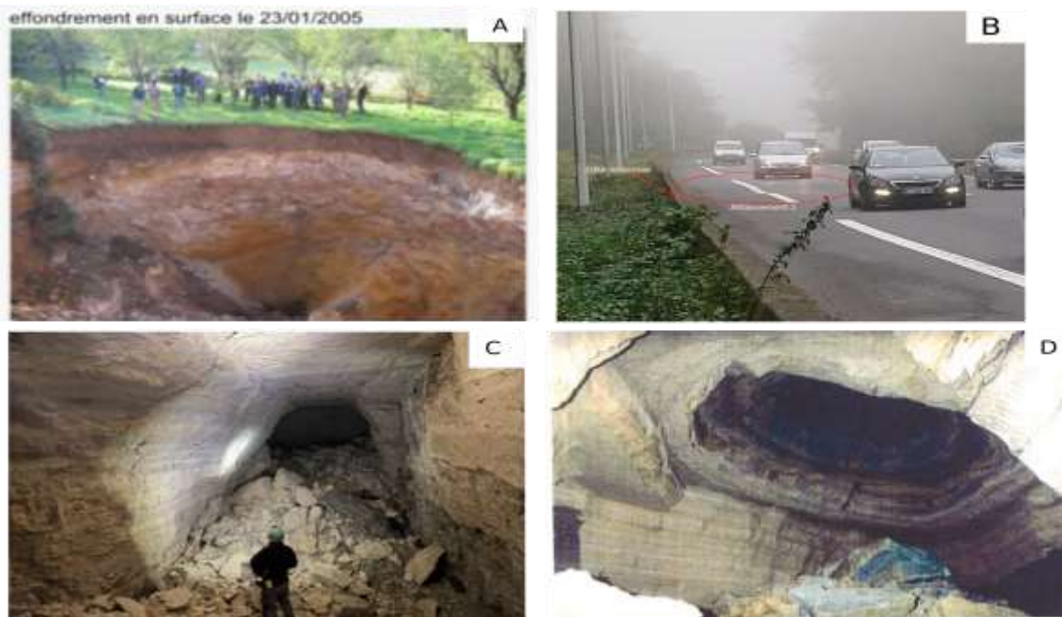
Figure 2 Photographie de remontée de fontis dans le gypse. (A) Effondrement de fontis à Roquevaire (13) (Cerema, 2018). (B) Affaissement de la chaussée de l'A15 (CEREMA, 2021). (C) et (D) Remontée de fontis en région parisienne (Lecomte, 2022) et (Direction régionale de l'industrie, de la recherche et de l'environnement, 1995)
