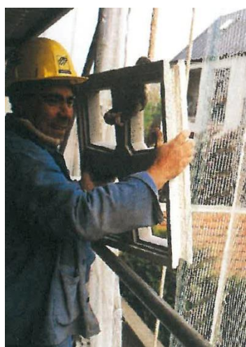
214 Pose de nouveaux claustras. Patrimoine restauré, N° 2, 1996. DRAC IDF.
