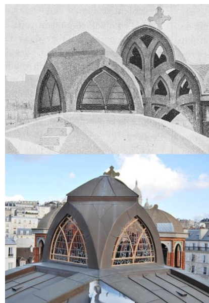
199 Les couvertures d'origine en ciment. Saint-Jean de Montmartre. État d'origine et couverture en cuivre posée en 1997. La Construction moderne , 15 avril 1905. Photo en bas : l'auteur, 2012.
