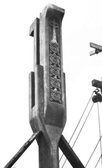
112 Saint-Christophe-de-Javel. Chapiteau d'un pilier pendant les travaux. CAAC. BESCH-G-20. 093 IFA.
