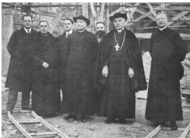
30 Visite du chantier de l'église du Sacré-Cœur à Saint-Ouen. De gauche à droite : l'ingénieur des travaux, R. P. Merklen, directeur de La Croix , l'abbé Poujol, le cardinal Verdier, le vicaire général Paul Louis Touzé. Derrière : l'architecte Julien Barbier et son fils. Le Christ dans la banlieue , N° 3, 1932.
