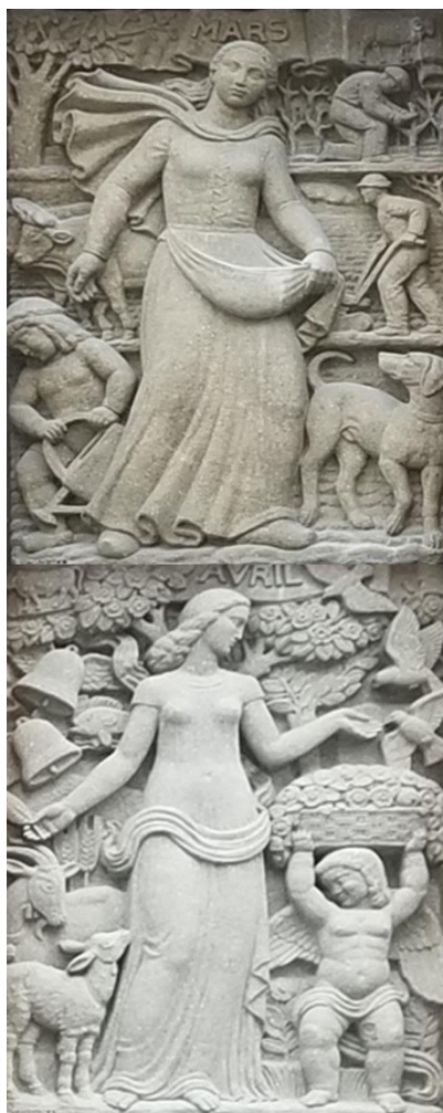
197 Comparaison des résultats de deux techniques de nettoyage du béton apparent. La teinte jaunâtre en haut peut être due à la projection d'abrasifs à basse pression. Église du Saint-Esprit, Paris. Photo : l'auteur, 2023.
