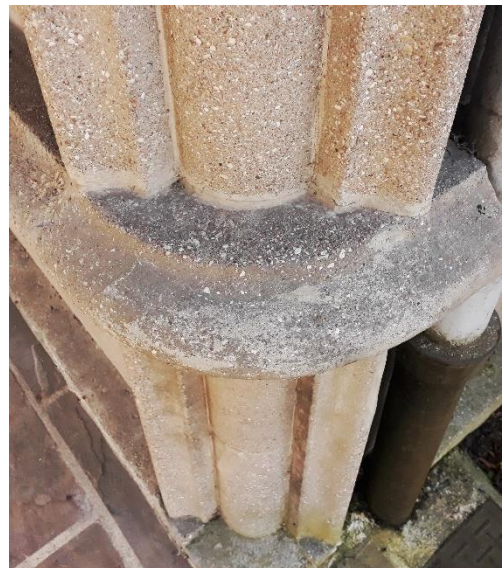
90 Notre-Dame, Rungis. Détail d'angle réalisé selon le brevet 401.478. Photo: l'auteur, 2017.
