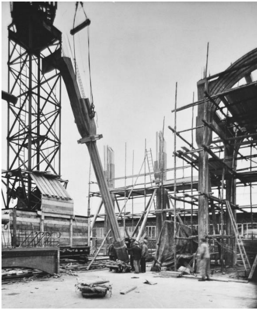
136 Notre-Dame-de-la-Trinité, Blois. Chantier de construction du projet de Ch.-H. Besnard. Montage d'un pilier en ciment armé préfabriqué. CAAC. BESCH-G-30-393. IFA 54/8.
