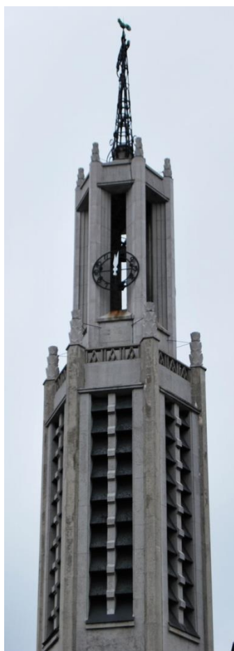
217 Clocher de l'église Sainte-Agnès restauré au début des années 2000. État en 2017. Photo : l'auteur.
