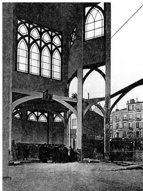
70 Photographie illustrant probablement l'inspection du Conseil des travaux de l'architecture sur le chantier de Saint-Jean de Montmartre, été 1900. G. Delhumeau. L'invention du béton armé .
