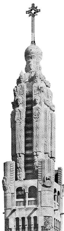
56 Saint-Louis de Villemomble. Clocher sculpté en béton par C. Sarrabezolles. La Construction moderne , 12 juin 1927.
