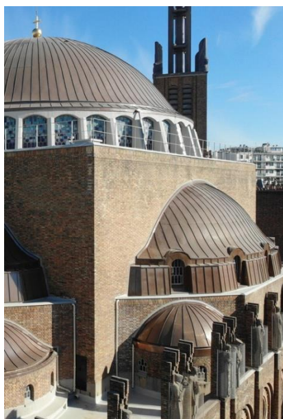
200 Saint-Esprit, Paris. Couverture en cuivre posée en 2021-2022. Photo : Ville de Paris.
