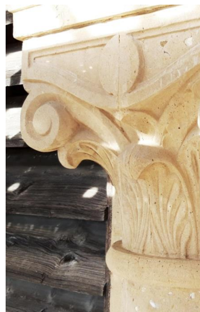
226 Chapiteau en béton moulé restauré. Photo : Licéf, 2022.
