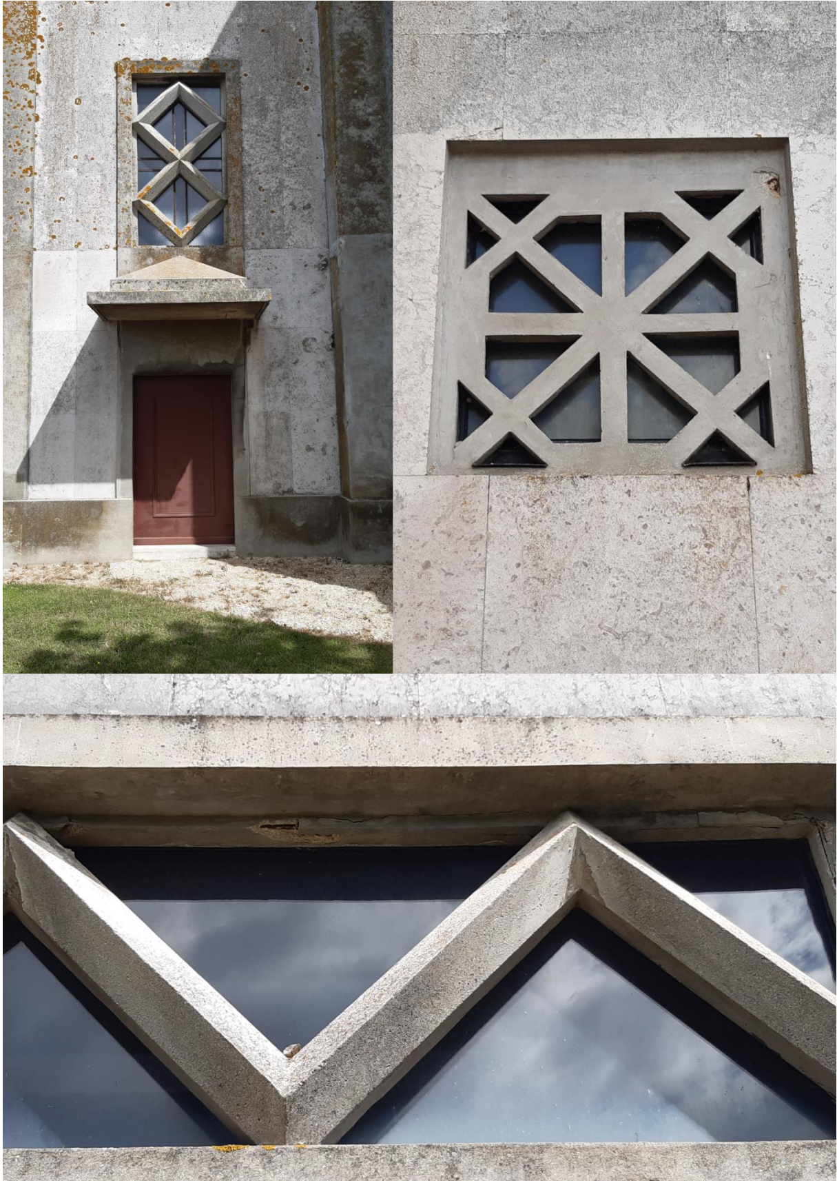
IV. Modernisme tempéré. Saint-Géry, Brie. Porte clocher sud. Fenêtre en façade Nord. Baie de la nef en façade Sud. Photo : l'auteur.
