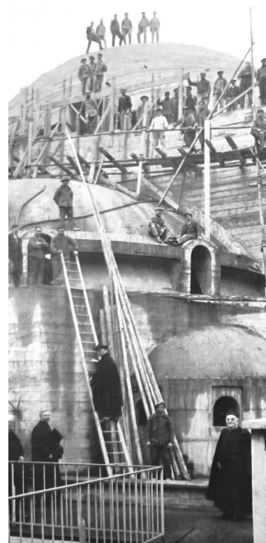
32 Le cardinal Verdier (centre) sur le chantier de l'église du Saint-Esprit. Le Christ dans la banlieue , N° 2, 1932.
