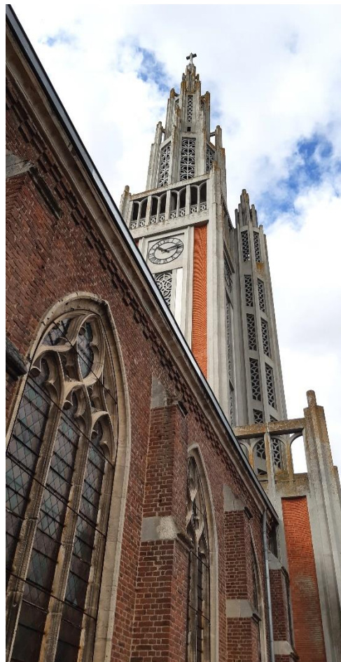
18 Saint-Vaast de Moreuil : Dialogue de matériaux entre la nef reconstruite au XIX e siècle et le clocher en béton armé peint des années 1930. Photo : l'auteur, 2023.
