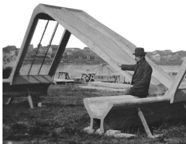
107 Shed en ciment armé Besnard. CAAC. 93 IFA 121.
