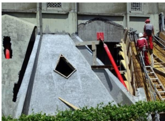
202 Remplacement total des ouvrages en béton armé. Notre-Dame, Royan. Couvertures des collatéraux. De gauche à droite : état d'origine, restitution, dispositif d'origine démolli, coffrage en cours de montage. Photo : ADER.
