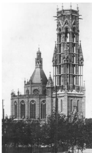
1 Sainte-Cécile du Havre. Le clocher en blocs préfabriqués de béton avant 1944. Carte postale, s.d.
