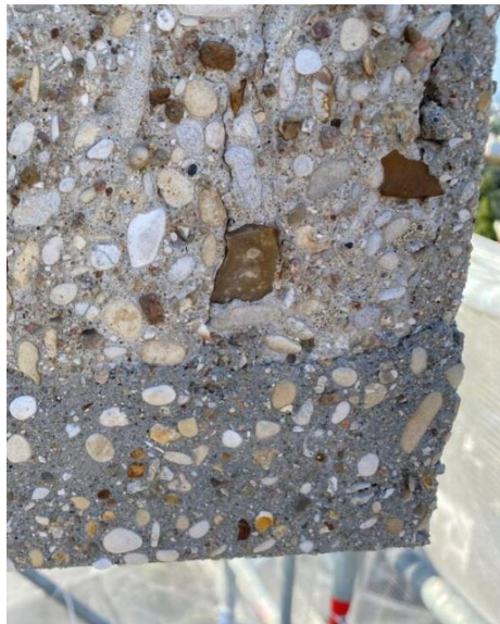
213 La restauration des années 1990. Reconstitution de la zone inférieure de la croix du clocher. Différence de teinte avec le béton d'origine. Photo : Chantiers du Cardinal, GF, 2022.
