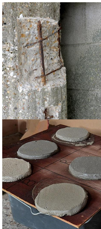
215 Chantier de restauration 2022-2023. Purge des fers sur une colonne du clocher. Échantillons de teinte. Photo : Chantiers du Cardinal, GF, 2022.
