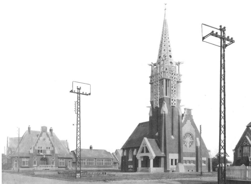
22 L'église Saint-Remi de Roupy et la nouvelle mairie. Vue générale. Léon Azéma, Documents d'architecture contemporaine .
