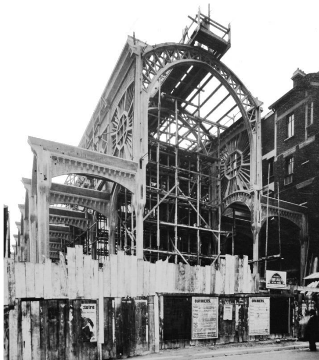
111 Saint-Christophe-de-Javel. Vue de l'ossature porteuse en ciment armé préfabriqué. CAAC. BESCH-G-20. 093 IFA 54/7.
