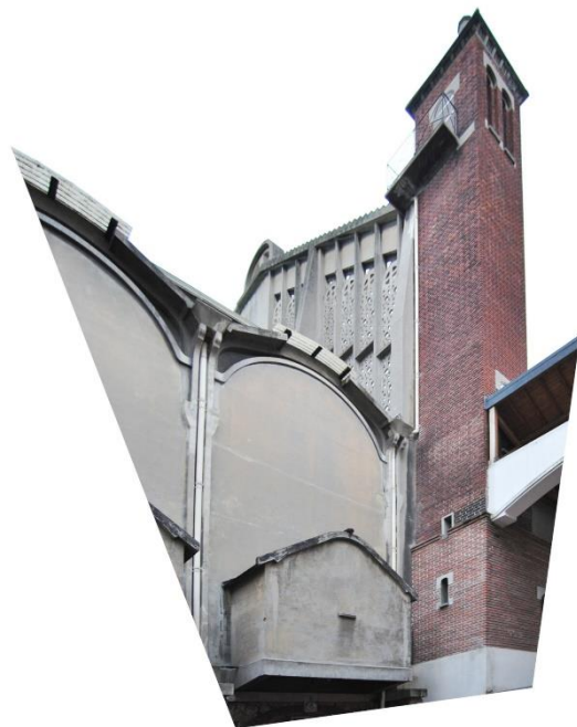
116 Saint-Christophe-de-Javel. Vue de l'angle sud-est : confessionnal en porte-à-faux, débords des toitures en ciment et revers du tympan de la façade principale. Photo : l'auteur, 2013.
