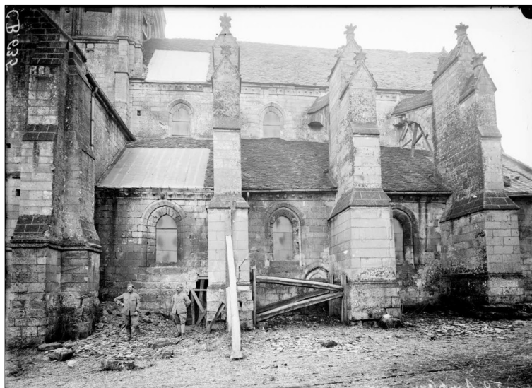
Figure 33 : Opérateur CB [Maurice Bauche], Travaux de protection de l'église d'Ambleny , février 1918, négatif, plaque de verre, 13 x 18 cm, Ivry-sur-Seine, ECPAD (CB000635). ©Bauche/SPCA/ECPAD/Défense/SPA 18 CB 635
