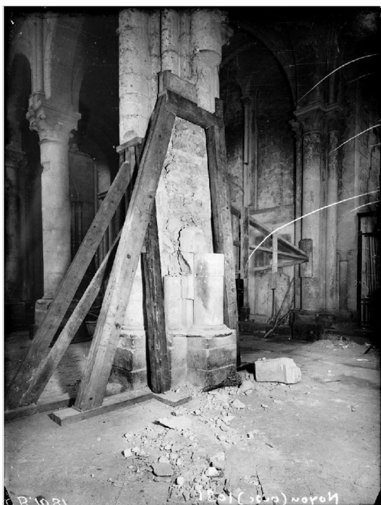
Figure 34 : Opérateur CB [Maurice Bauche], Étalement définitif de piliers intérieurs de la cathédrale de Noyon , octobre 1918, négatif, plaque de verre, 13 x 18 cm, Ivry-sur-Seine, ECPAD (CB001081). ©Bauche/SPCA/ECPAD/Défense/SPA 30 CB 1081
