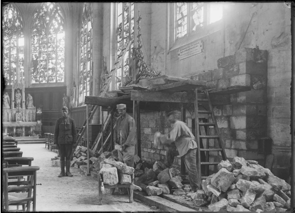
Figure 87 : Opérateur BO [Maurice Boulay], Protection du Saint-Sépulcre de Ligier Richier (mur intérieur) , octobre 1918, négatif, plaque de verre, 13 x 18 cm, Ivry-sur-Seine, ECPAD (BO002298). ©Boulay/SPCA/ECPAD/Défense/SPA 52 BO 2298
