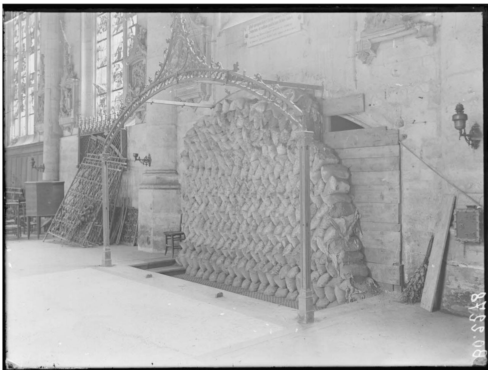
Figure 85 : Opérateur BO [Maurice Boulay], Protection du Saint-Sépulchre de Ligier Richier avec des sacs de sable , octobre 1918, négatif, plaque de verre, 13 x 18 cm, Ivry-sur-Seine, ECPAD (BO002278). ©Boulay/SPCA/ECPAD/Défense/SPA 52 BO 2278
