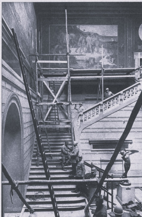
Échafaudages dressés par des pompiers de Paris pour démaroufler les toiles de Fuviss de Chavannes décorant le vestibule et le grand escalier du musée. — Section phot. de l'Armée.
