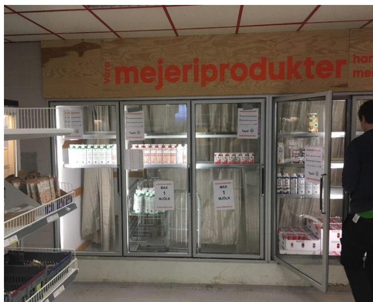
Figure 37. Armoires frigorifiques pour les produits laitiers
