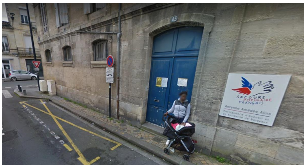
Figure 32. Entrée des bénéficiaires, 43 rue Deyries
