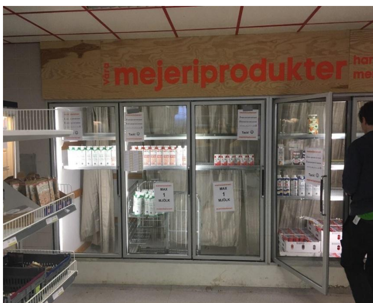
Figure 37. Armoires frigorifiques pour les produits laitiers
