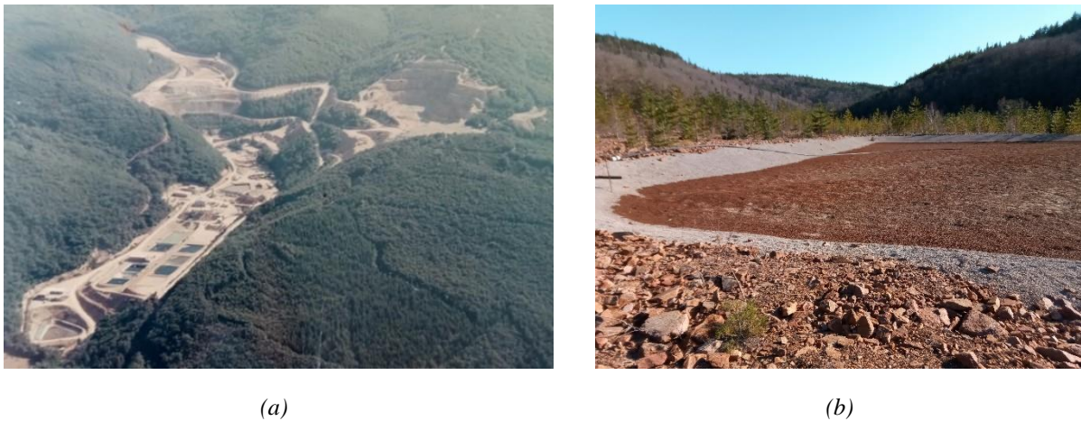
Figure 1.4 : (a) Site de Bertholène en exploitation en 1992 (à l'arrière-plan se trouve le stockage de résidus et la mine à ciel ouvert et au premier plan se trouve les différents bassins de traitement des eaux et les stalles de lixiviation) et (b) stockage de résidus avec une alvéole de stockage des boues de traitement des eaux en 2019.
