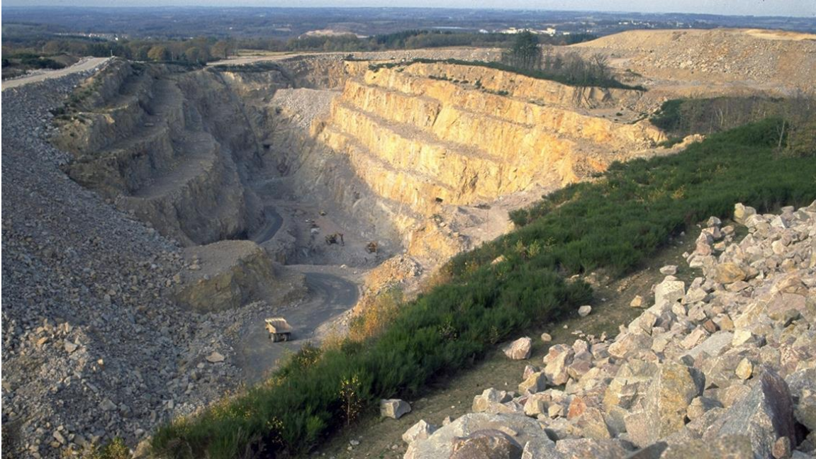
Figure 2.1 : Mine à ciel ouvert en exploitation de la mine d'uranium de Bellezane dans les années 1980 (source : ORANO).
