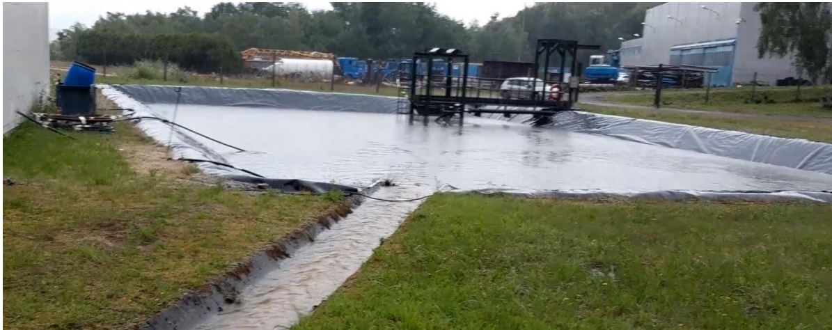
Figure 4.36 : Photographie du bassin de réception BZN1 le 13 juillet 2021 lors de l'orage de 77 mm en une journée.
