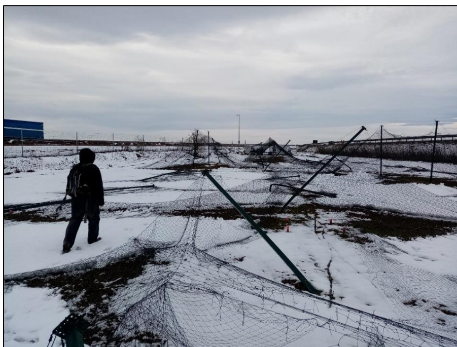
Figure 3 : Enclos détruit en janvier 2021. Le poids de la neige accumulée sur le filet anti-prédateurs aériens a plié les poteaux qui le soutenaient. L'enclos a été reconstruit à l'été 2021 ce qui ne nous a pas permis de l'utiliser à nouveau pour les expérimentations présentées dans l'Article 3 (Crédit : L. Garnier).
