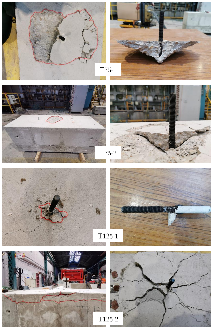
Figure 97 : Profils de rupture des chevilles chimiques après chauffage au portique radiant
