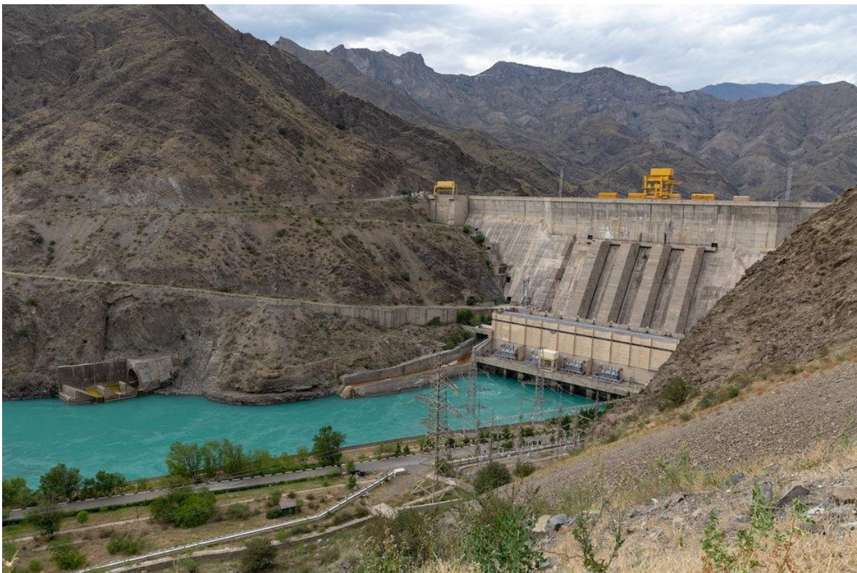
Figure 67 Photographie du barrage de Toktogul, (Eurasianet, 2022)
