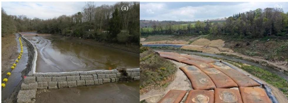
Figure 10 : Sédiments contaminés du ruisseau de l'Yvrande (a) et sac de ressuyage en amont de Vezins (b).
