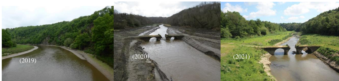
Figure 11 : Changement de niveau d'eau et de paysage au niveau de la République : (European Rivers Network, 2022 ; OPP La Sélune, 2013). En 2020 les berges ont été travaillées de manière à créer une géométrie en forme de rectangles emboîtés pour limiter l'érosion induite pour des débit importants.
