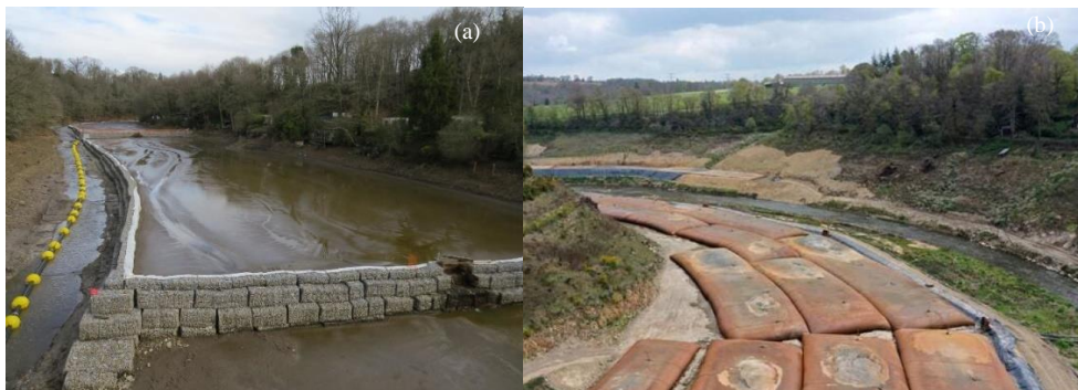
Figure 10 : Sédiments contaminés du ruisseau de l'Yvrande (a) et sac de ressuyage en amont de Vezins (b).
