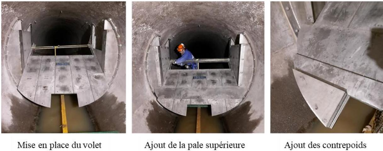
**Figure 6-24. Etapes successives de la mise en place du volet basculant**
