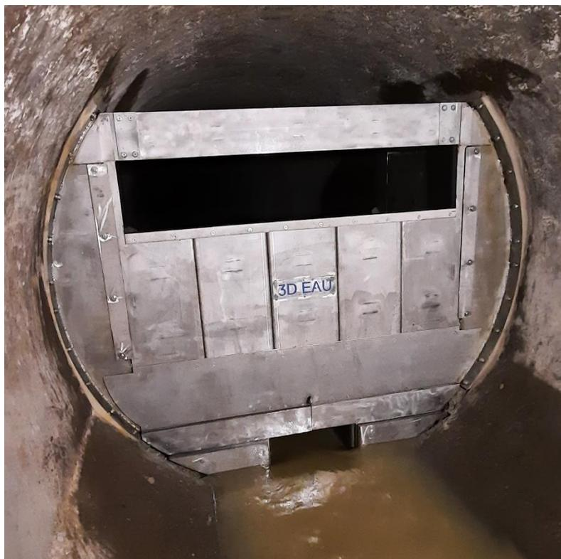
**Figure 6-25. Vanne mise en fonctionnement dans le réseau**
