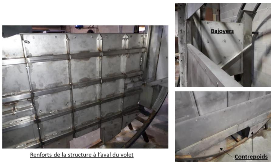
Figure 6-21. Vues sur les renforts à l'aval du volet, les bajoyers et les contrepoids
