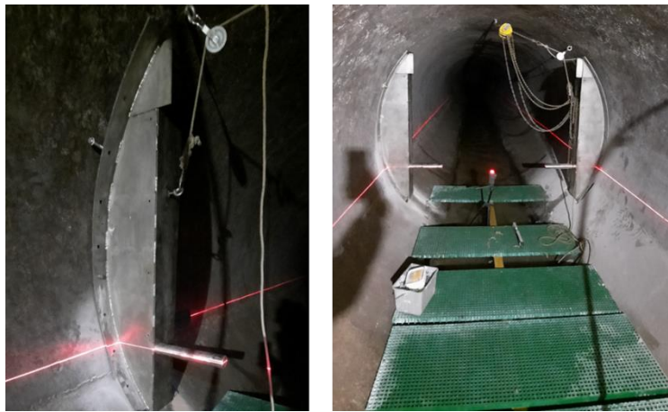
Figure 6-22. Alignement des joues et de l'axe de rotation avec un plan laser selon les altitudes définies lors du dimensionnement
