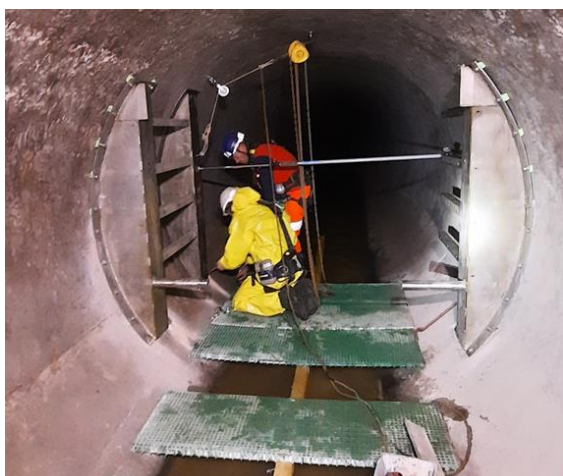
Mise en place des renforts pour les bajoyers
