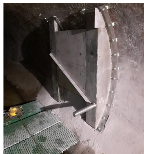
Mise en place des bajoyers et butée
