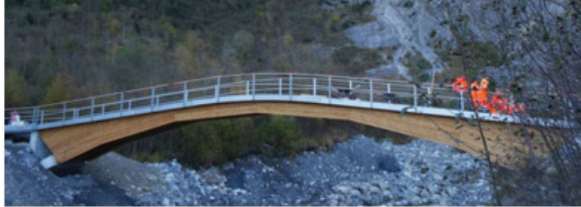
Figure I.14 : structure en bois-BFUP en Suisse (passerelle à Grindelwald)
