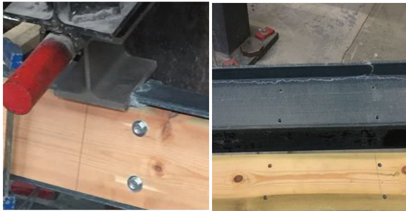
Figure II.62: poutre HCW1.1 testée jusqu'à rupture
