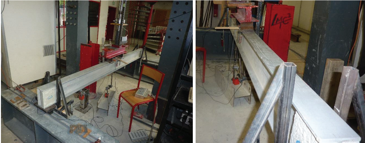
Figure A.10 : poutre composite Co3 testée jusqu'à rupture par déversement
