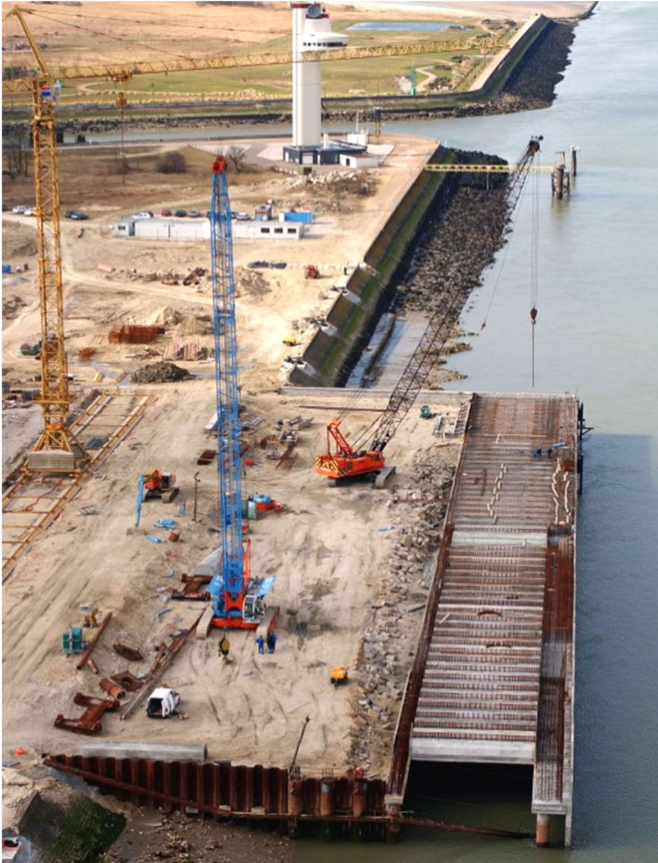
Photo 17. Construction du 3 e Quai en Seine du port d'Honfleur (Haropa), Calvados (photo : société EMCC)
