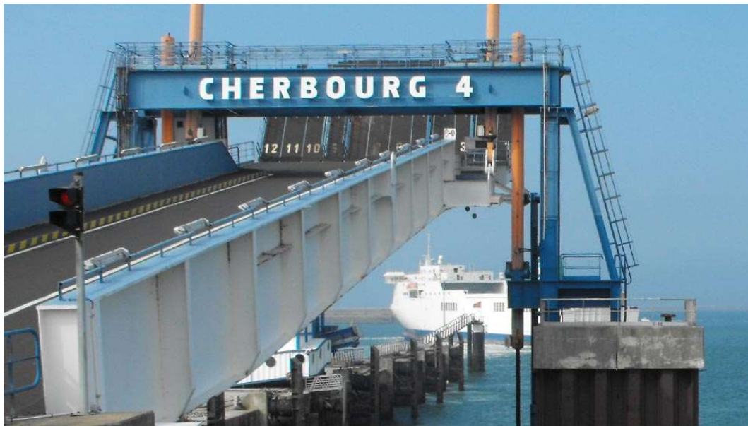
Photo 1. Poste n°4 pour car ferries , port de Cherbourg, Manche (Photo : Ports de Normandie)
