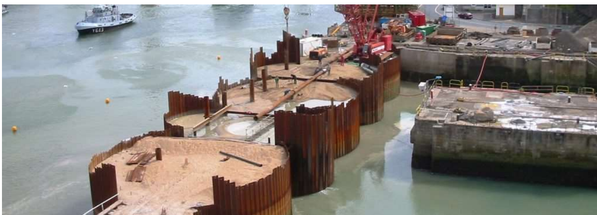
Photo 8. Gabionnade en construction sur le port militaire de Brest, Finistère (Photo : Arcelor-Mittal)
