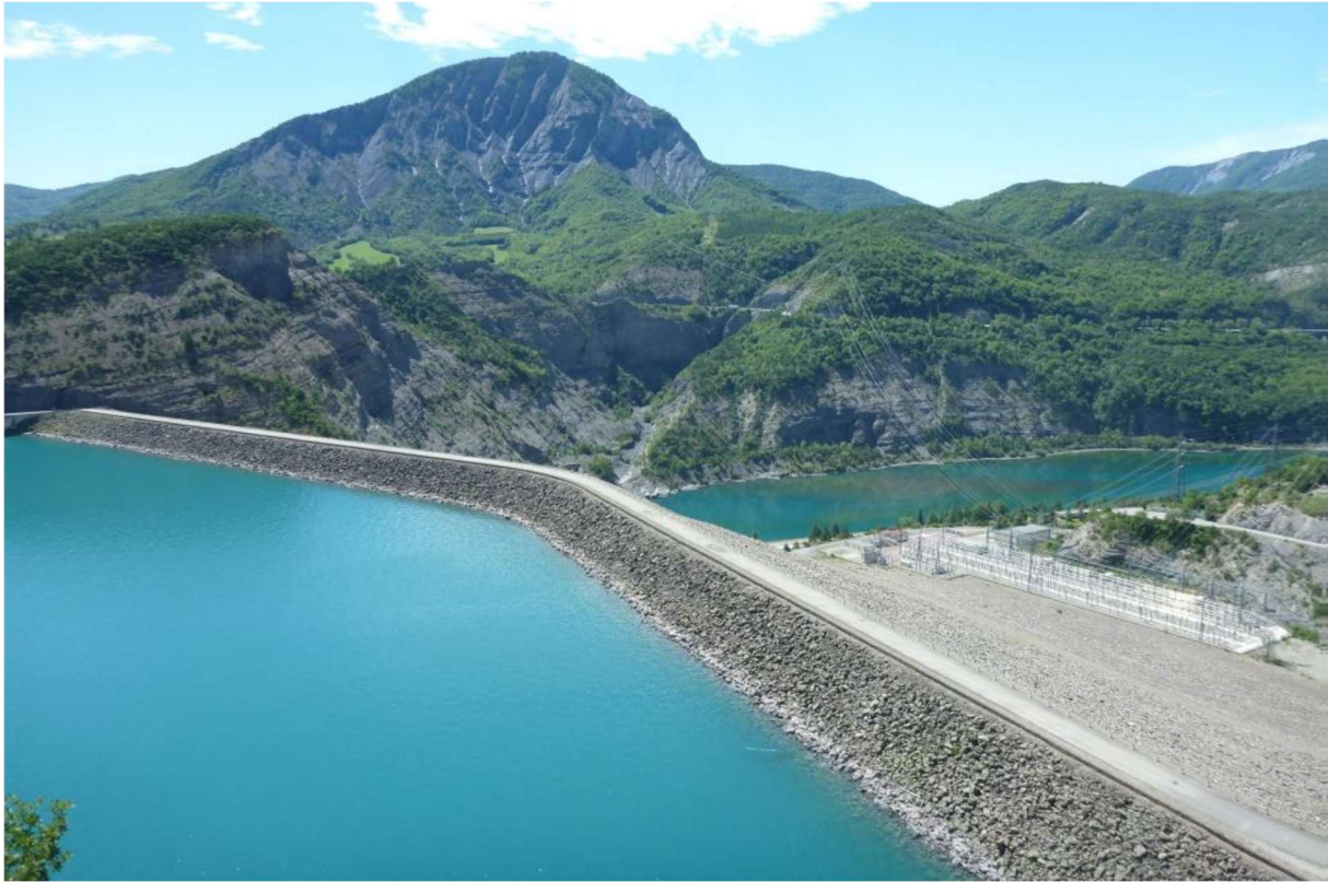
Photo 7. Barrage de Serre-Ponçon, Hautes-Alpes (Photo : EDF – Benoît Blancher)
