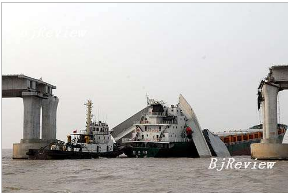
Photo 15. Collision contre le pont Jin Tang, Ningbo, Chine, le 27 mars 2008 (Photo : Beijing Review)
