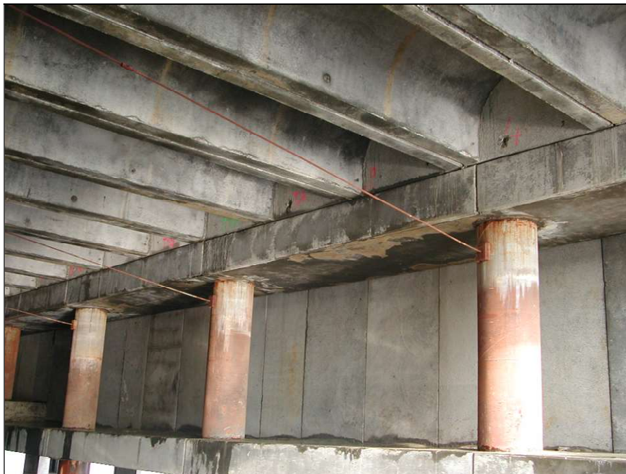
Photo 14. Pieux supportant la dalle du 3 e Quai en Seine du port d'Honfleur (Haropa), Calvados (Photo : EMCC)
