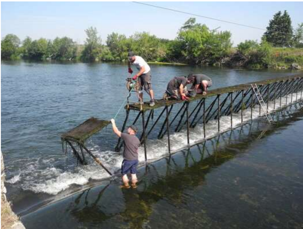
Photo 5. Exploitation du barrage à aiguilles de Larçay, Indre-et-Loire (Photo : ParenthèsesUrbaines)
