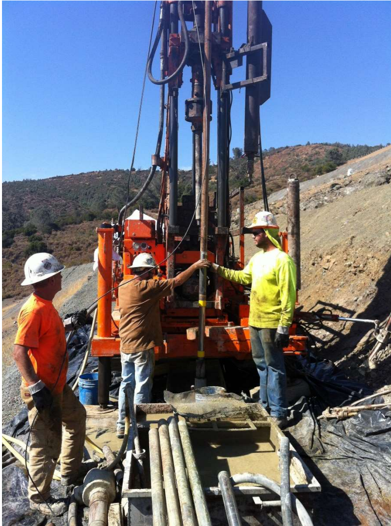
Photo 9. Sondage géotechnique (Photo : Roctest)
