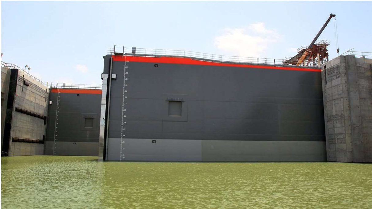
Photo 6. Portes coulissantes des nouvelles écluses du canal de Panama (Photo : EPA / Alejandro Bolivar)
