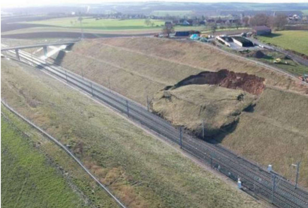
Photo 16. Quel est le « coefficient de sécurité » du talus ? Rupture de talus de la LGV Est à Ingenheim, Bas-Rhin, ayant entraîné un déraillement le 5 mars 2020 (Photo : rapport d'enquête technique du BEATT)
