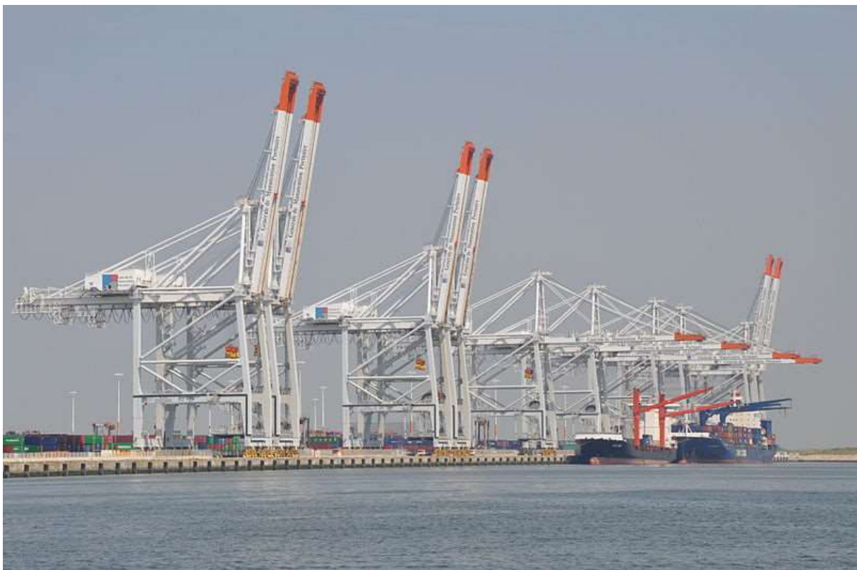
Photo 12. Quai « Port 2000 » pour l'accueil de navires porte-conteneurs, Le Havre (Haropa), Seine-Maritime (Photo : Philippe Alès, sous licence Creative Commons)
