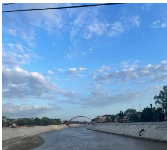
Photo 2 : Vue du Piura depuis le pont de Cáceres (district de Piura).
