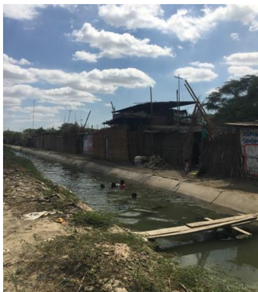
Photo : Sofía Castro, date : 29.01.2018
