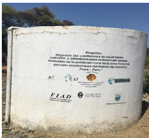
Photo 1 : Noria (puits) dans le hameau Suena el Agua
