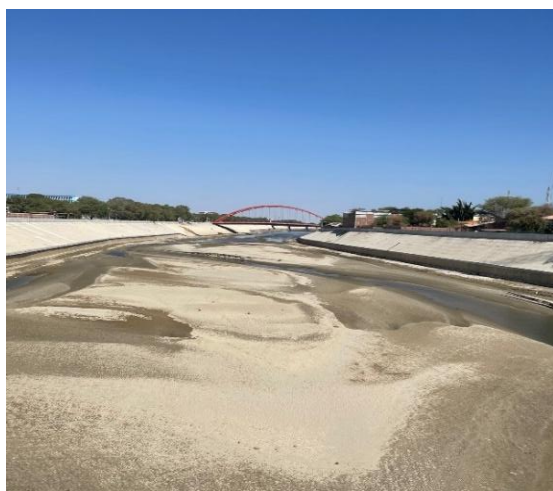
Photo 1 : Vue du Piura depuis le pont de Cáceres (district de Piura). Basse saison des eaux.
