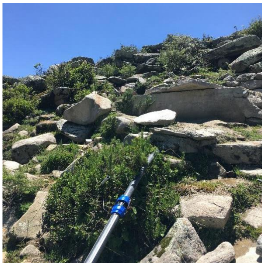
Photo 3 : Canalisation découverte près du puits de Potaga
