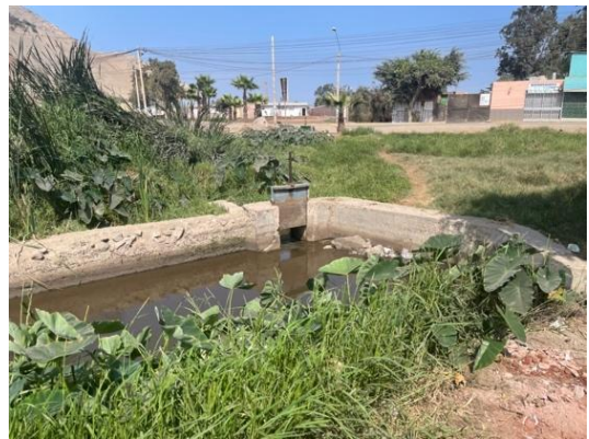
Photo 6 : Canal Buenavista, pollué par les eaux usées des habitations. Altitude : 30 m au-dessus du niveau de la mer. Date : 12.06.2023
